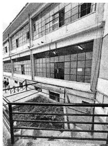
Foto N°06 : Ventanales en mal estado.
