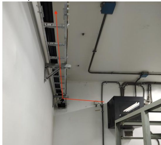
Ruta cableado desde gabinete hacia cámaras y Access point
