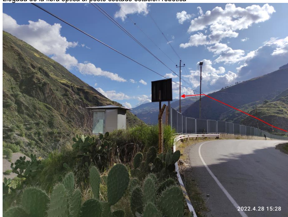
Instalación de gabinete en poste, soporte metálico y cámara
