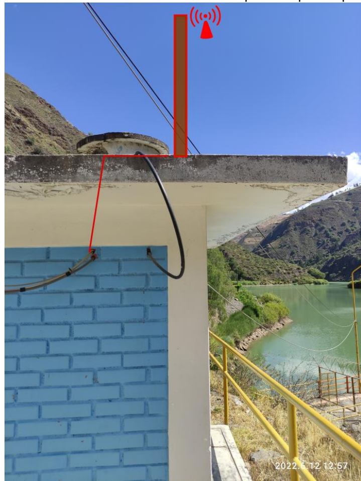
Cableado e instalación de nuevo Access point en primer poste margen derecha dique
