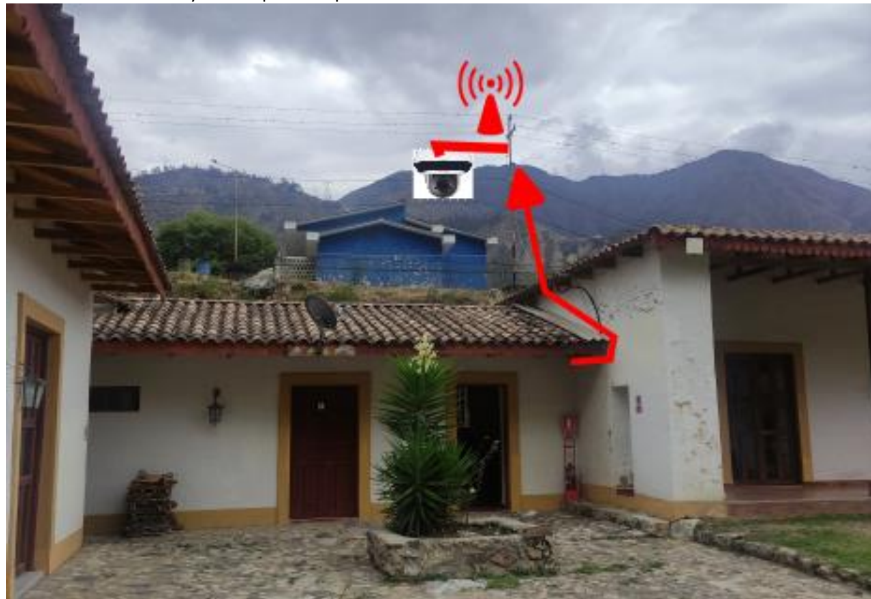
Instalación de cámara y Access point en poste
