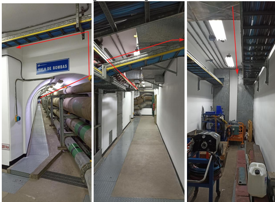
Cableado a teléfono bodega RON desde gabinete sala de bombas
