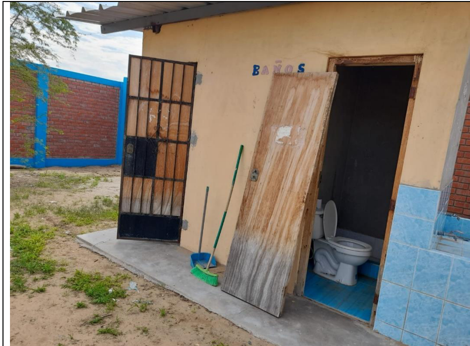
Fotografía N° 01: Servicios higiénicos de la IE donde se puede apreciar el techo de calaminas y el mal estado de la puerta,
