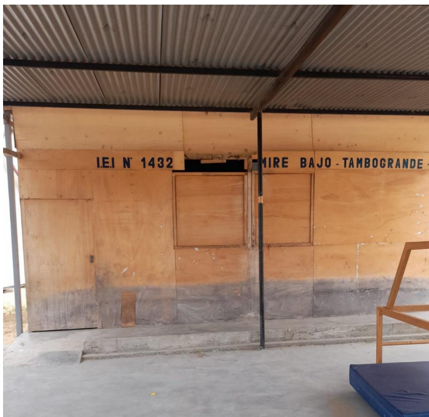
Fotografía N°03: Vista exterior del almacén de la IE que presenta material triplay como elemento constructivo.
