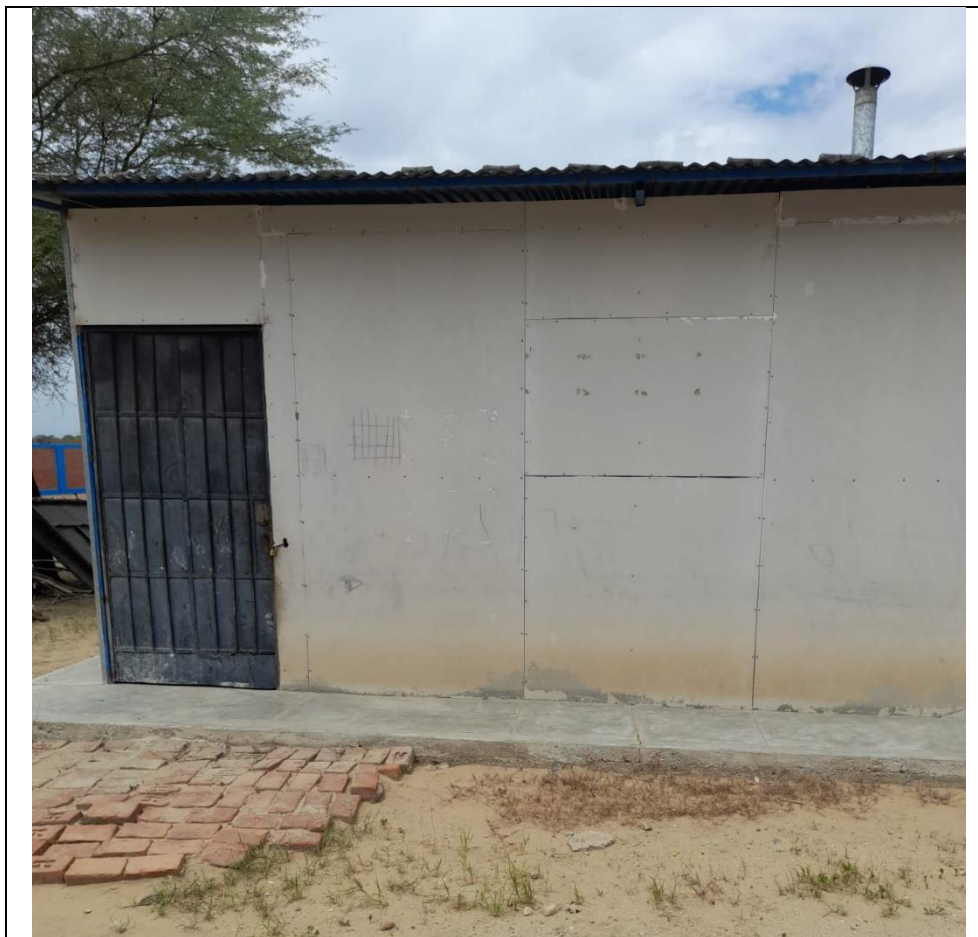
Fotografía N°04: Se muestra la parte externa de la IE de material precario (triplay)
