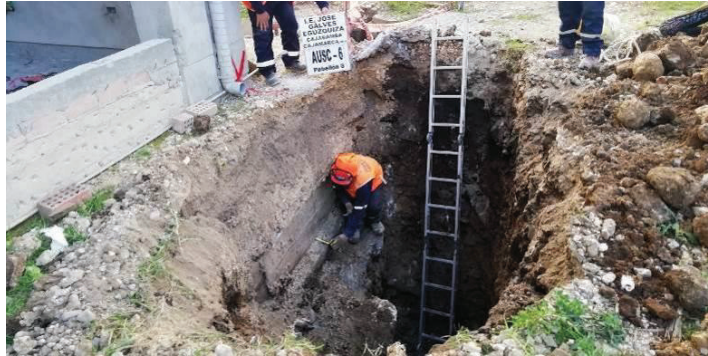
Figura 8 Auscultación de cimentación
