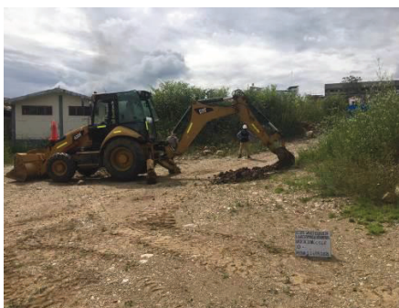
Figura 6 Excavación de calicata con retroexcavadora
