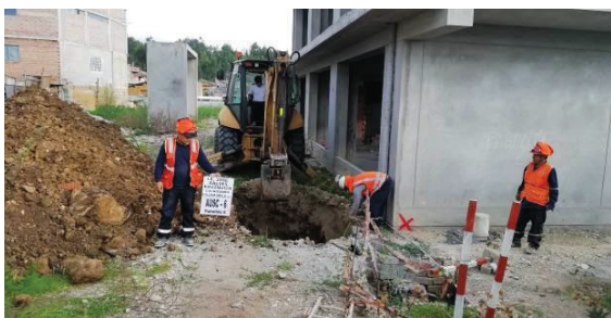
Figura 7 Ejecución de auscultación de pabellón existente con retroexcavadora
