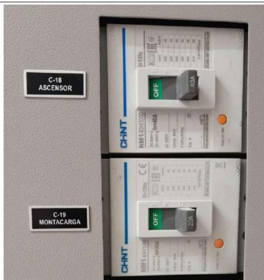
Térmicos Eléctricos destinados para el ascensor y montacarga.
