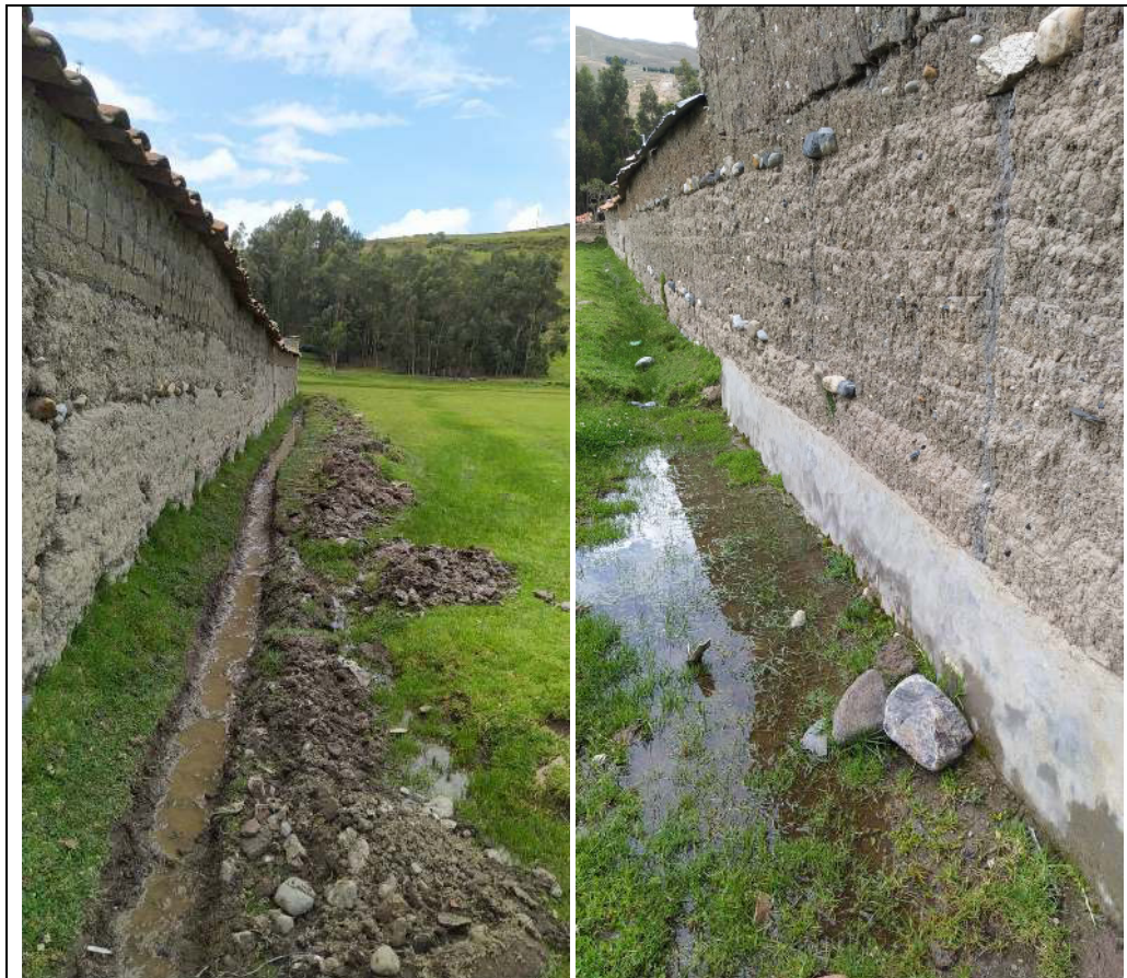
Fotografía N°04 y 05: Se visualiza cerco perimétrico erosionado, presencia de agua a falta de elementos o sistema de evacuación pluvial.
