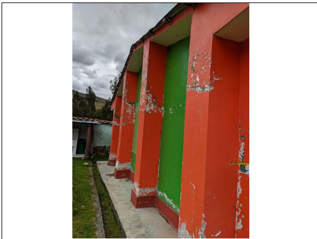
Fotografía N°06: Se visualiza muros del Pabellón N°01 (aulas 1 y 2), se aprecia fisuras y humedad en la base de muros.
