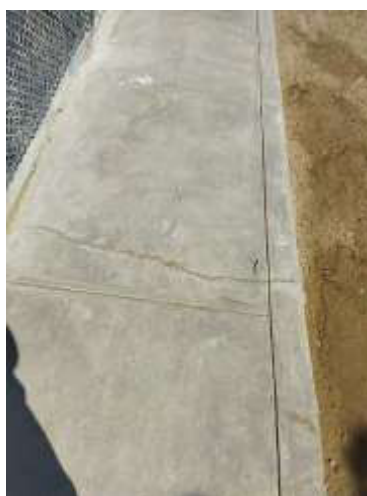
Fotografía N°05: Se muestra las veredas existentes con fisuras dañadas por el sismo.
