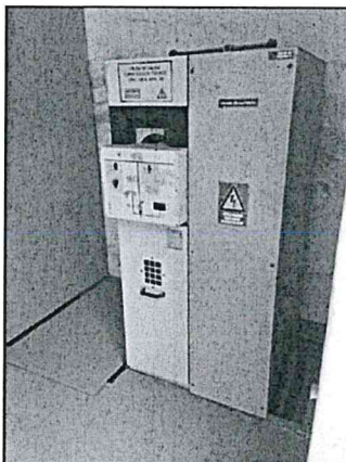
CELDA DE LLEGADA Y PROTECCION
