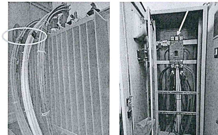
Imágenes de conductores de salida de transformador de potencia 630 kVA (imagen derecha) y punto de llegada en tablero general (imagen derecha)
