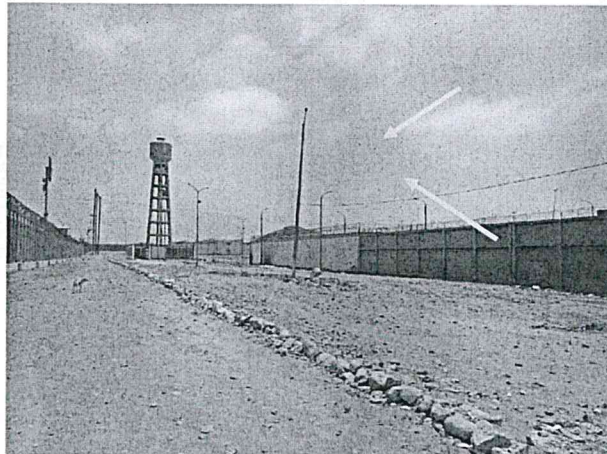
Poste inclinado con pastoral doble (incluye luminaria na 250 w)
