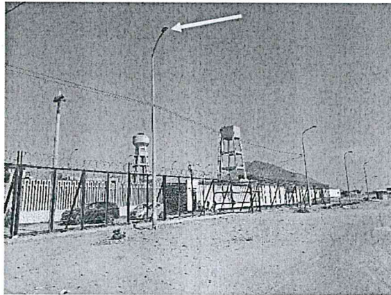
Luminarias con pastoral simple (1 luminaria na 250 W por poste)
