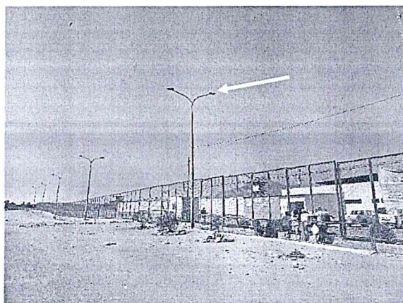
Luminarias con pastoral (2 luminarias na 250 W por poste)
