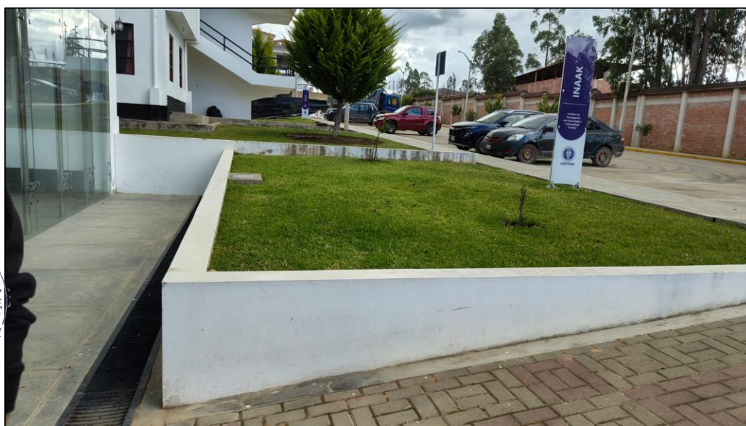
Imagen N°16: vista del deterioro que presenta el sardinel exterior, desprendimiento de pintura, manchas, etc.
