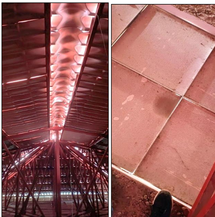
Imagen N°18: vista de la presencia de agujeros y apertura de la cobertura, además de la evidencia de agua sobre la baldosa.
