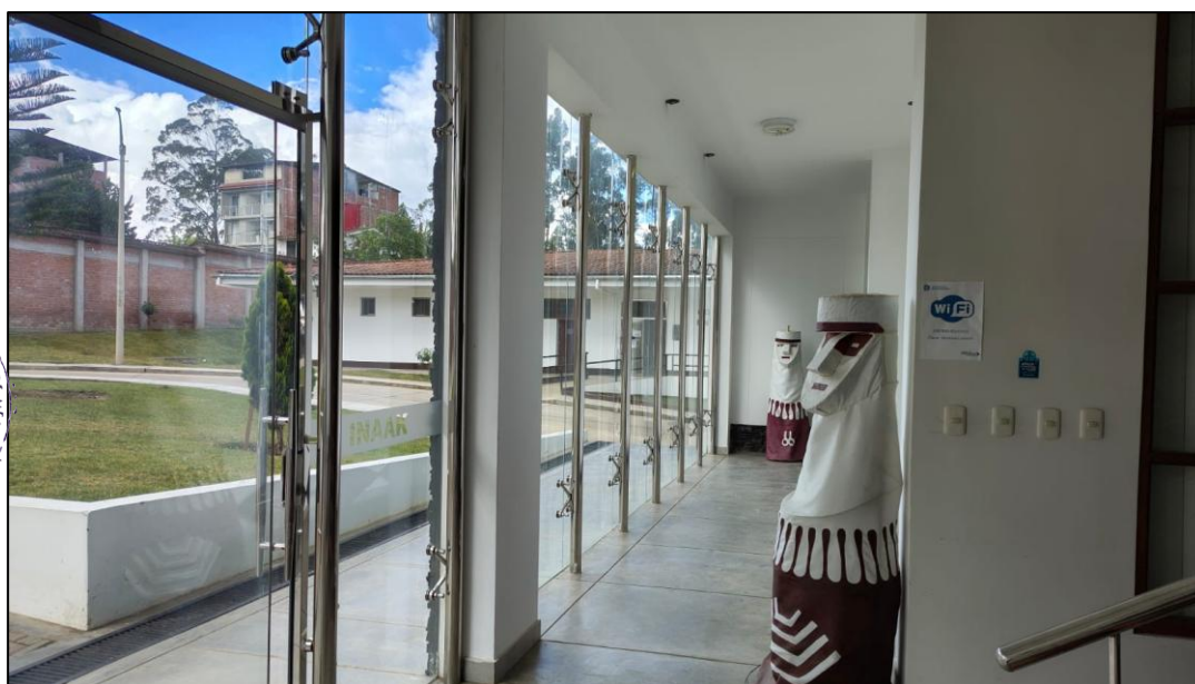
Imagen N°15: vista de la mampara exterior que no cuenta con vinil autoadhesivo para la identificación de esta.
