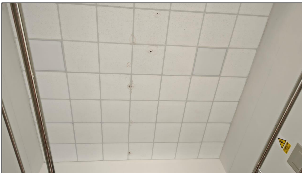
Imagen N°14: vista del deterioro que presenta el falso cielo raso a causa de filtraciones de agua producto de las lluvias y el deterioro de la cobertura existente.
