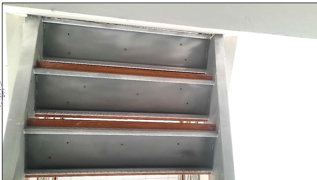
Imagen N°09: vista de la escalera metálica con peldaños de madera, los pernos de sujeción se encuentran sueltos y algunos peldaños carecen de la misma.
