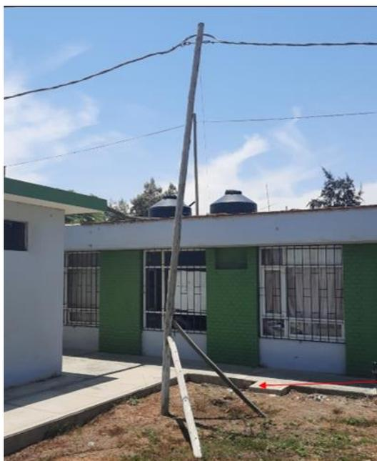
Como se observa en la imagen hay un RIESGO ELÉCTRICO, es un palo que está soportando la red de baja tensión y encima se encuentra apoyado en 2 palos de 2 metros para que no se caiga.
