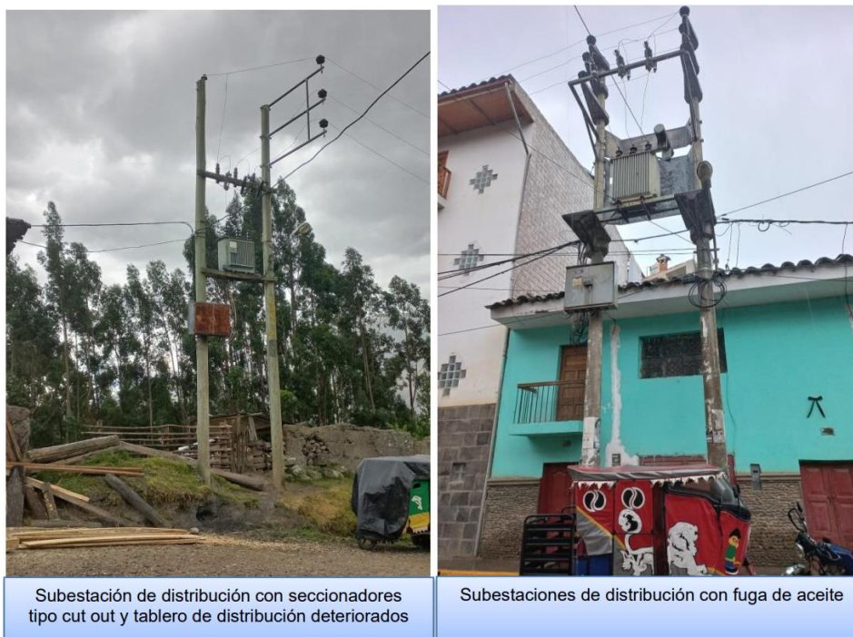
Figura N° 08 Subestaciones de distribución antiguas y con deficiencias
