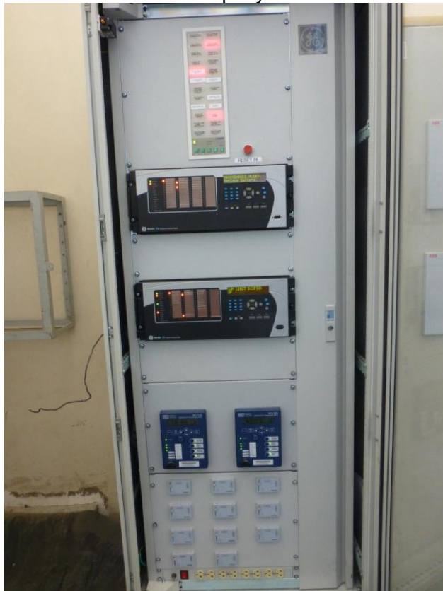
Figura 5 SET Chilina Tablero de transformador T3-1-31
