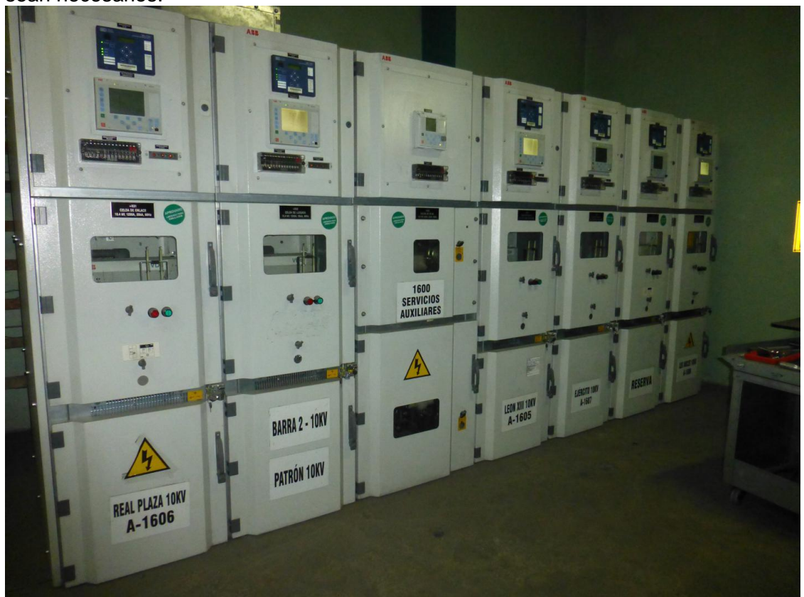
Figura 4 SET Real Plaza Celdas 10 kV
