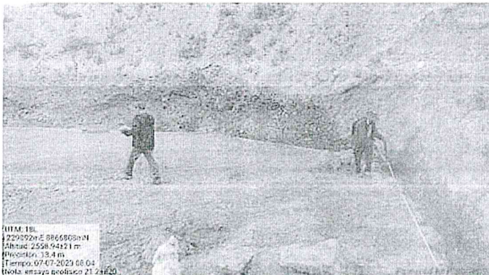
Foto N°09. Se verifico la ubicación de un tramo de canal, donde hubo deslizamiento de material tierra con piedras de gran tamaño (de 3" a 25" de diámetro), es necesario que el consultor realice los ensayos geofísicos correspondientes, para el mejoramiento de este tramo de canal.
