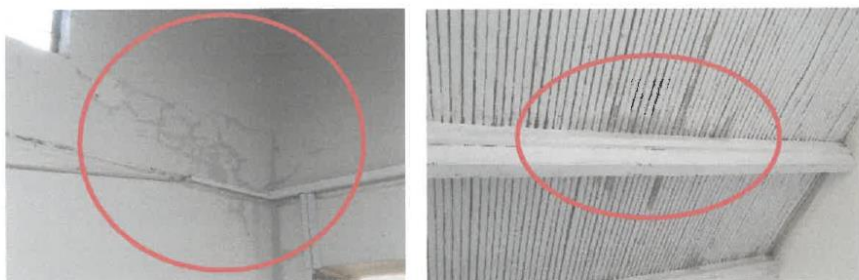
Foto N°06: Vista del cielorraso de caña del espacio de la Unidad Formuladora, donde se presenta filtraciones, Lo cual genera un daño a los elementos estructurales.
