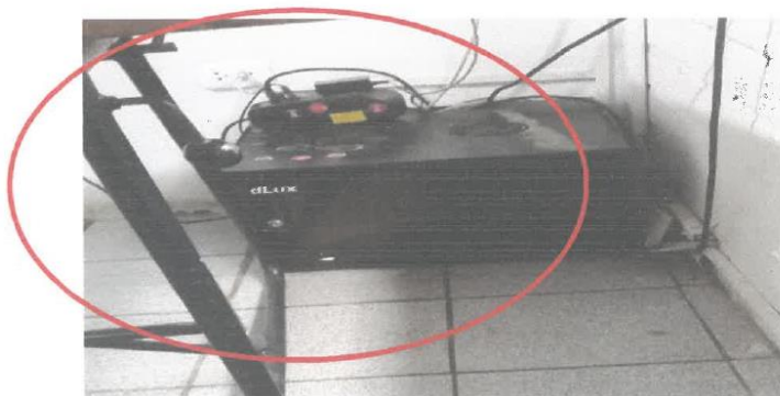
Foto N°14: Vista de los equipos de internet que se encuentran en riesgo de sufrir un desperfecto por estar en contacto con el agua.
