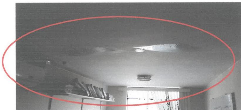
Foto N°13: Vista del cielorraso de la Oficina de la Unidad Formuladora en donde se presenta filtraciones y daños a los elementos estructurales y a los equipos y útiles de trabajo.
