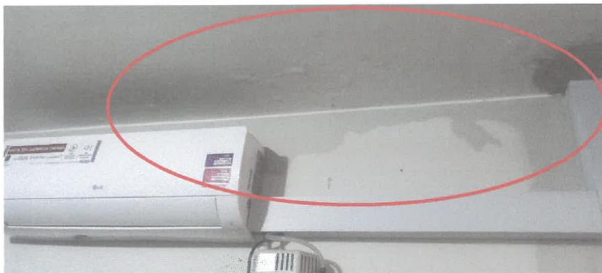
Foto N°04: Vista de las Oficinas administrativas en donde se presenta filtraciones y daños a los equipos de aire acondicionado.
