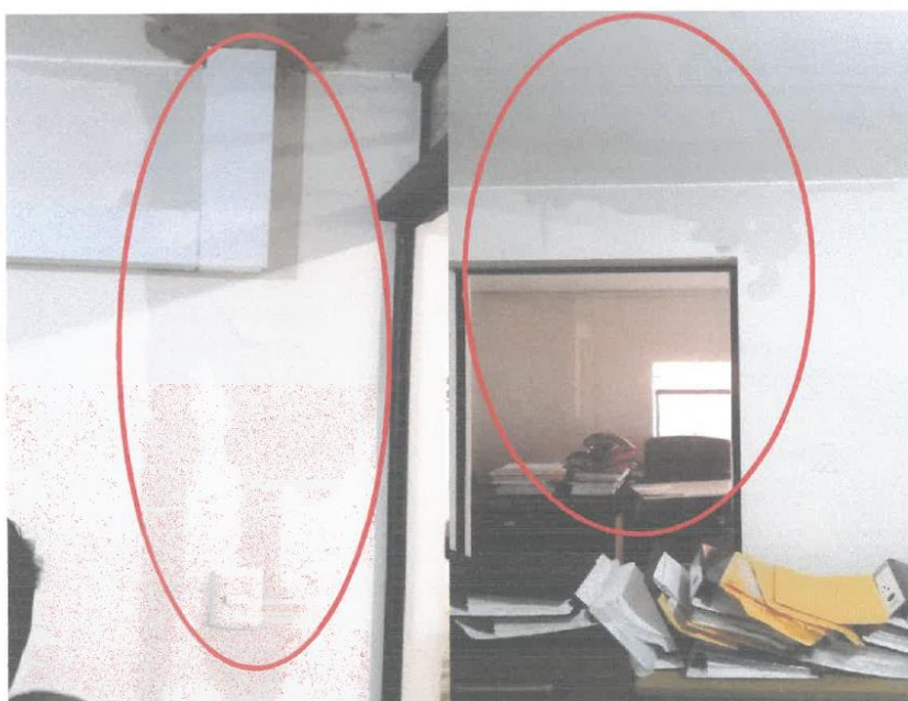
Foto N°09: Vista del de las Oficinas de Unidad Formuladora en donde se presenta filtraciones, Lo cual genera un daño a los elementos estructurales y a los equipos de cómputo y útiles de trabajo.
