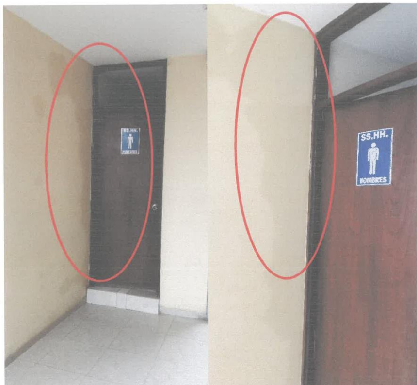
Foto N°15: Vista de los servicios higiénicos, en donde se presenta filtraciones lo cual ocasiona daños a los elementos estructurales de la infraestructura.
