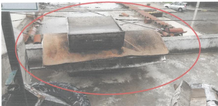
Foto N°19: Vista del condensador del aire acondicionado de la oficina de UF, el cual necesita protección para evitar que sufran desperfectos, se trató de colocar protección con elementos no adecuados por lo que requiere con urgencia contar con protección.
