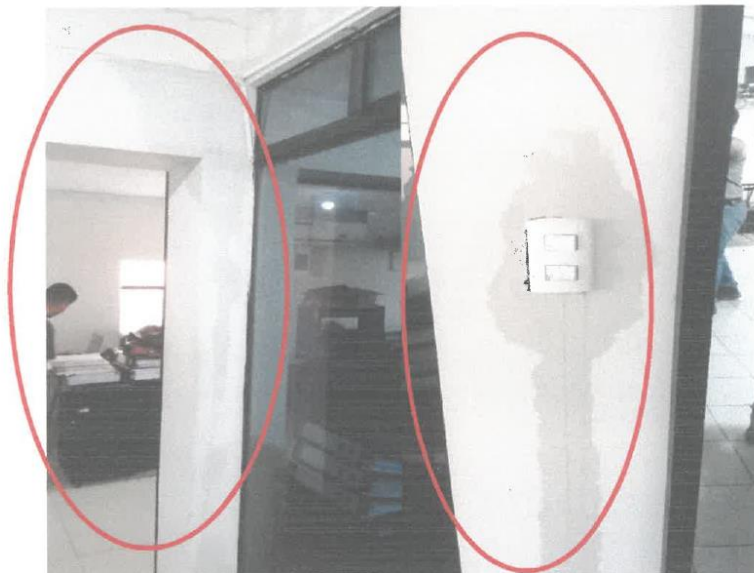
Foto N°010: Vista del de las Oficinas Unidad Formuladora en donde se presenta filtraciones, Lo cual genera un daño a los elementos estructurales y a los equipos eléctricos (interruptores) y útiles de trabajo.
