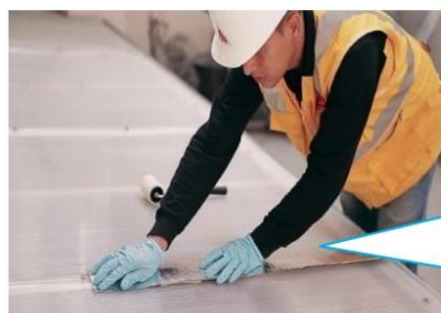
Proceso de instalación de la cinta
