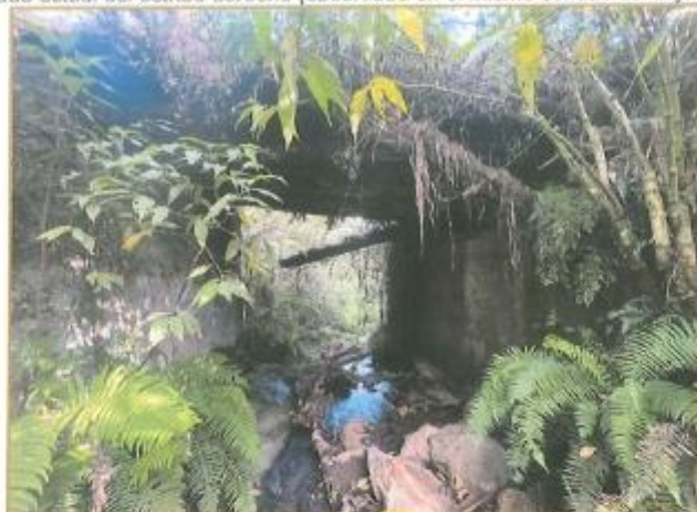
Figura 2: Estado actual del puente, no tiene veredas y barandas de seguridad en mal estado
