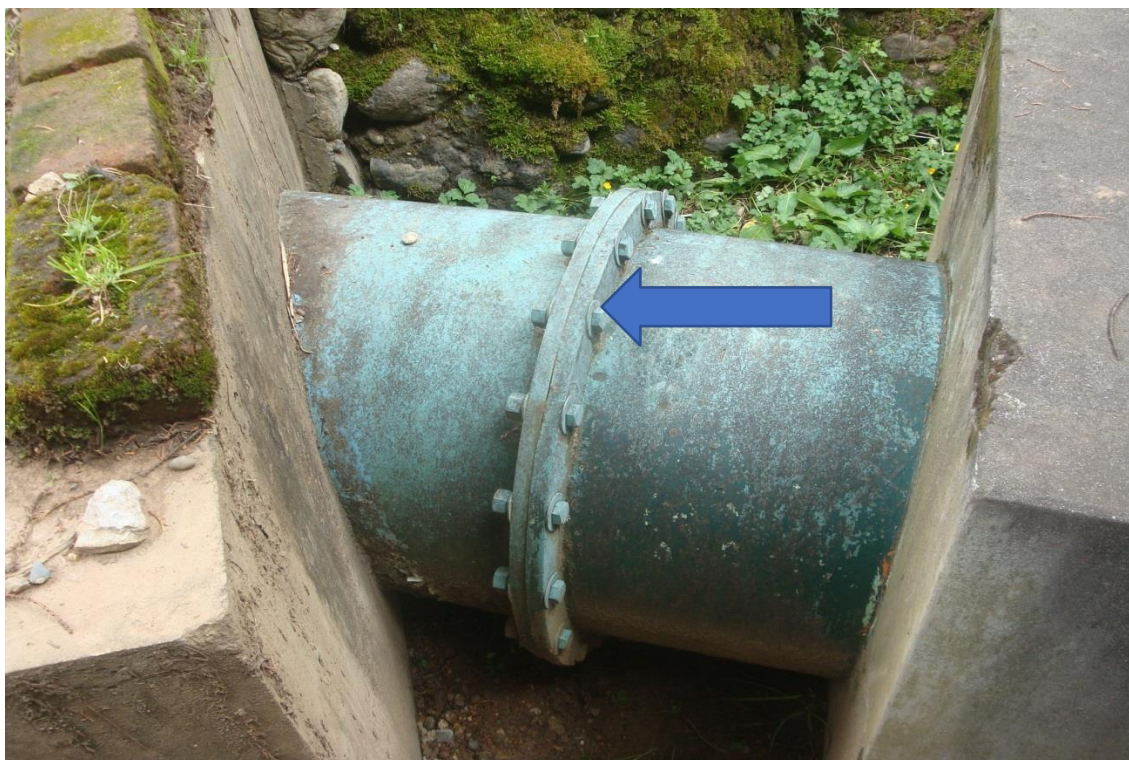
Foto N° 01: Unión embrizada donde se inicia en cambio de tubería de ingreso a la turbina.
