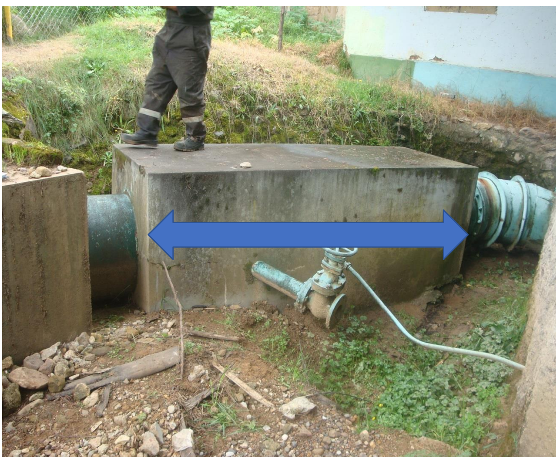
Foto N° 02: Tramo donde se aprecia el anclaje a demolerse y cambio de tubería, se nota el codo De
