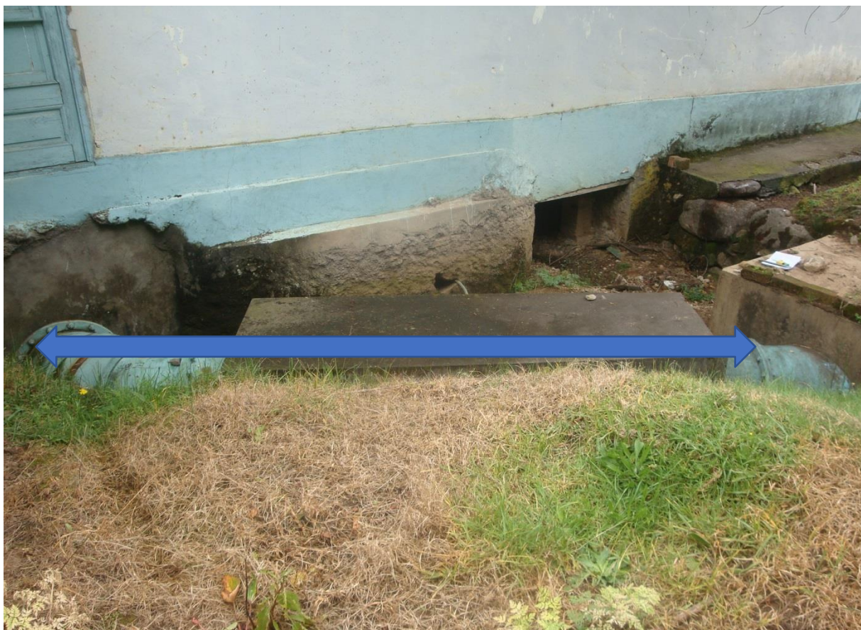
Foto N° 03: Codo de la tubería de presión, ingreso a la turbina a ser cambiado.
