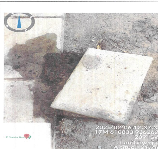
Fig.03. y 04. Cajas de registro y aparatos sanitarios en mal estado
