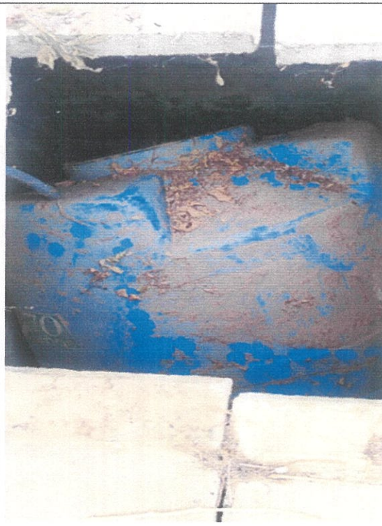
Fig.03. y 04. Cajas de registro y aparatos sanitarios en mal estado
