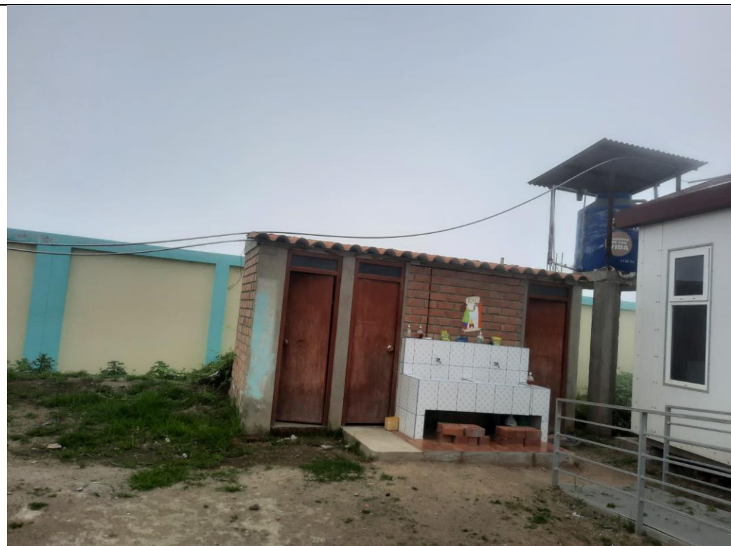
Fotografía N°04: Se visualiza el SS.HH, la infraestructura carece de acabados en pisos y paredes interiores, su funcionamiento es el adecuado, el techo es de fibrocemento
