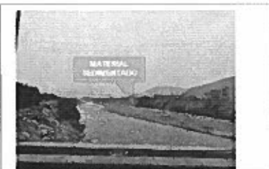
FIGURA N° 03: MATERIAL COLMATADO EN EL CAÑAL DEL RIO RIMAC, CON UNA PROFUNDIDAD APROX. 1.5M, ESTO PROVOCA QUE DESBORDAMIENTO DE LOS BAURGUES SEA MAS FUERTE.
