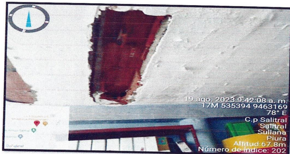
IMAGEN 03: Daño estructural en las viguetas del cielo raso – Daño estructural
