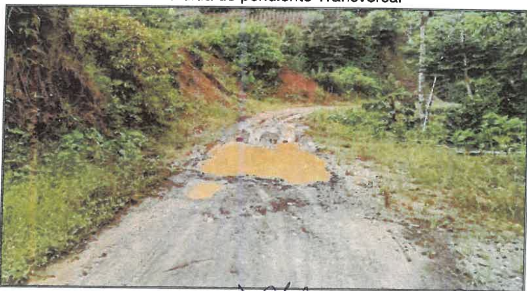
Fotografía N°04: Perdida de pendiente transversal y ahuellamiento Pérdida de pendiente Transversal
