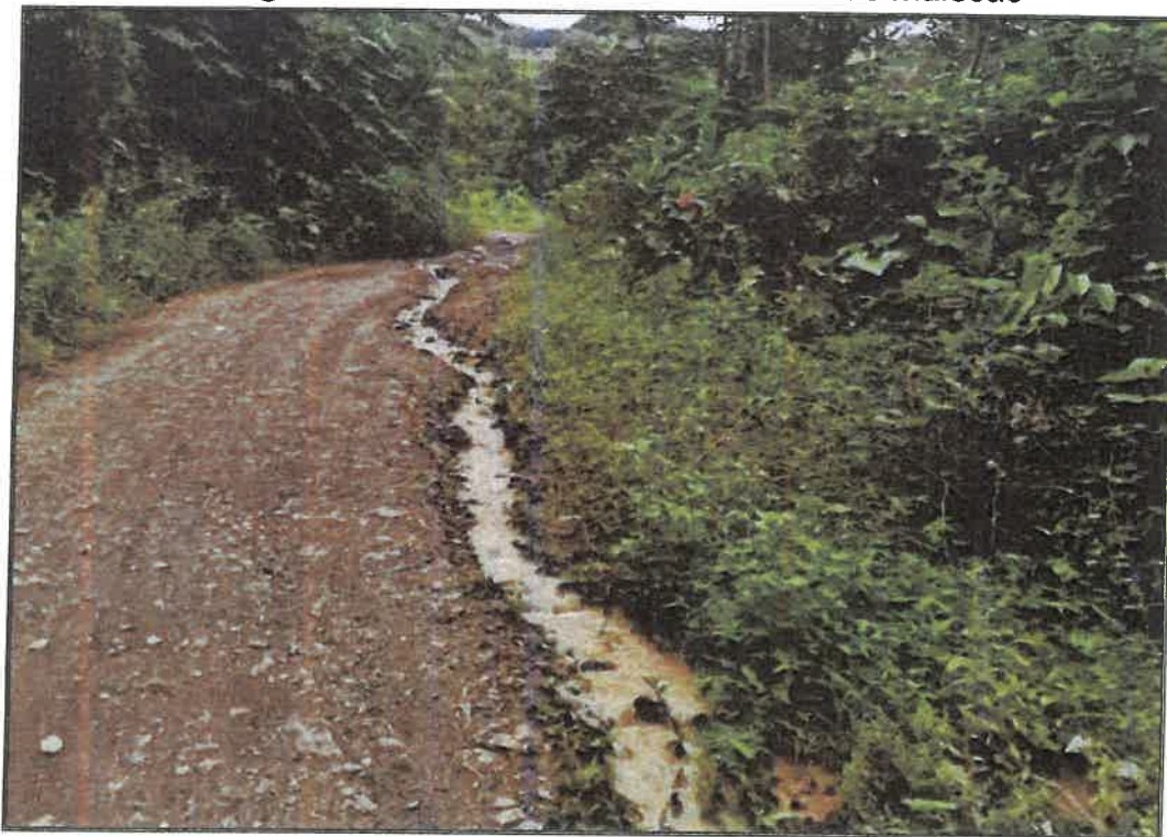
Fotografía N° 06: Cunetas coberturadas de malezas
