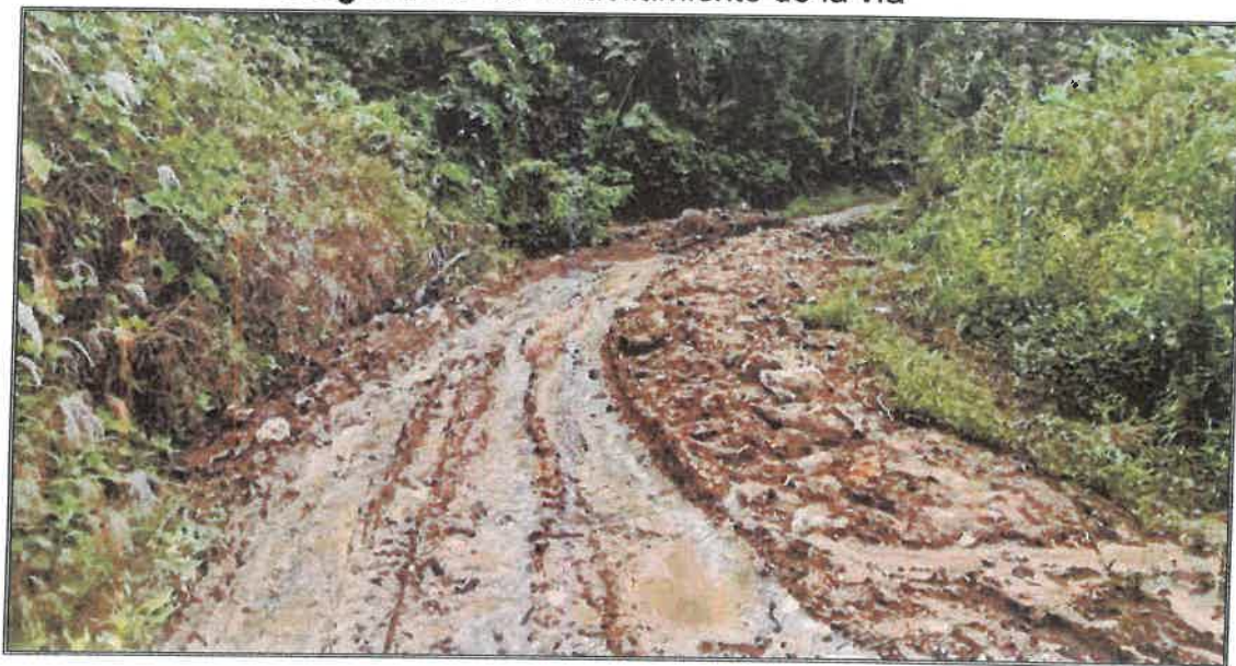
Fotografía N°03: Ahuellamiento de la vía
