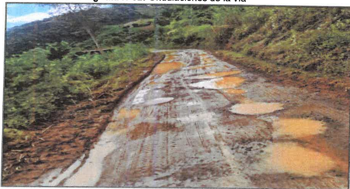
Fotografía N°02: Ondulaciones de la vía
