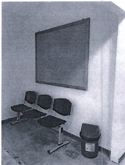
Imagen N° 04: piso vinílico en mal estado de conservación Fecha: 24/02/2023
