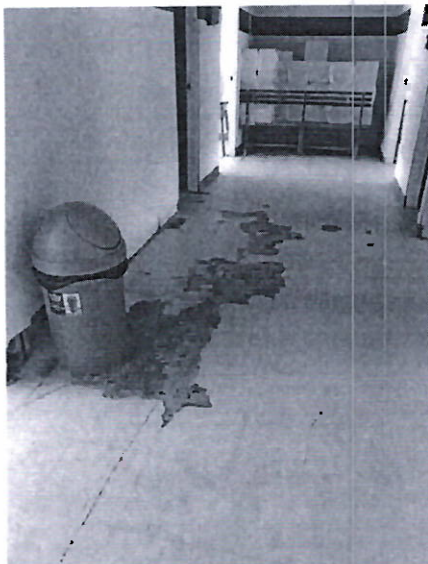
Imagen N° 05: piso vinílico en mal estado de conservación Fecha: 24/02/2023
