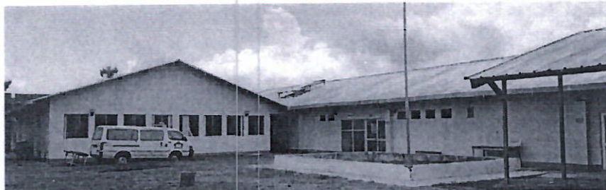
Imagen N° 01: Fachada donde se divide el mal estado de conservación de la calamina de policarbonato Fecha: 24/02/2023
