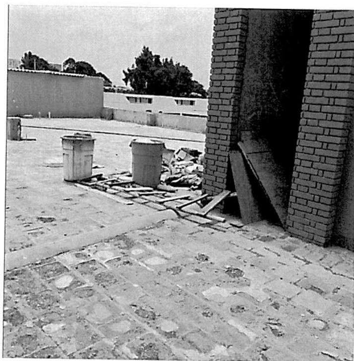
Foto N°05: Ladrillo pastelero en mal estado
