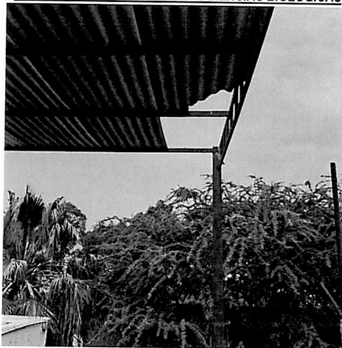
Foto N°01: Cobertura en mal estado
