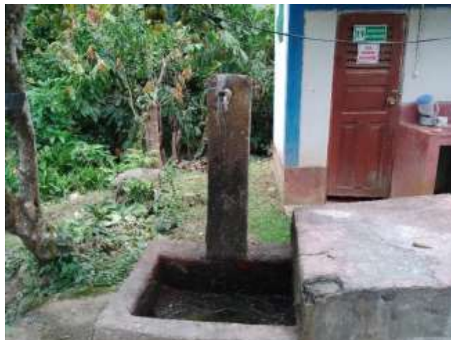
Vista de la estructura de la pileta de uso común en mal estado de conservación. Se plantea refacción integral.
