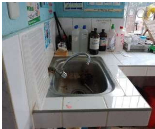
Vista del grifo tipo gancho de lavadero desprendido. Se propone cambio del accesorio. Ambiente laboratorio
