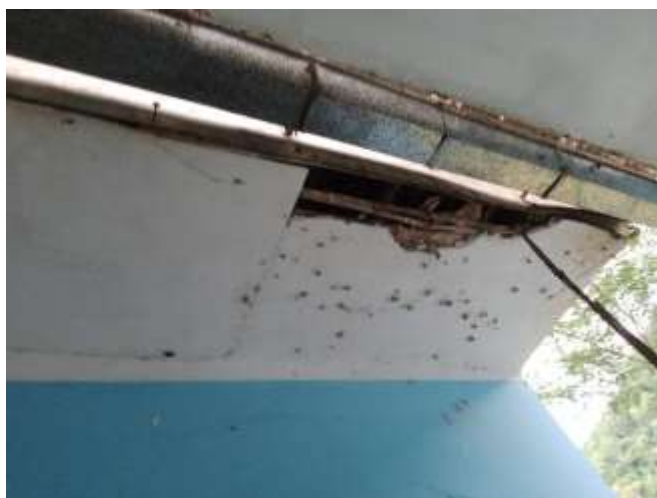
Vista a detalle desprendimiento del tratamiento del alero, causado por la humedad. Se plantea refacción y repintado. Alero frontal de la casa materna.
