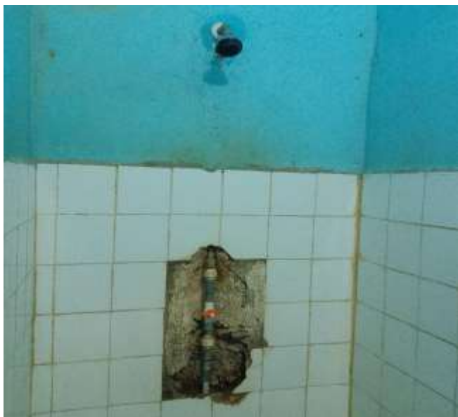
Vista de la llave y cabezal de ducha en mal estado. Se plantea cambio de los accesorios y colocación de cerámico.
