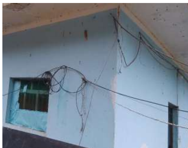
Vista que detalla el cableado provisiona en la parte externa del bloque de residencia. Se plantea la reinstalación.
