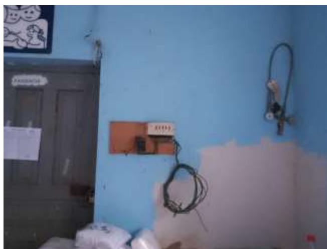
Vista donde se aprecia la instalación eléctrica, rollo de cable y puntos que no están en uso. Se propone el retiro. Residencia
