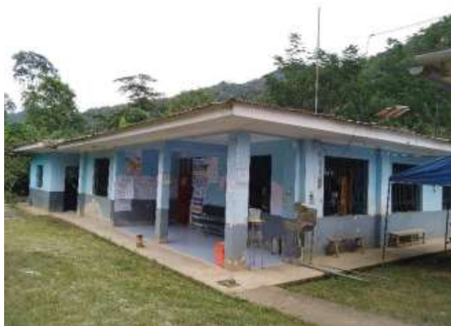
Vista de la fachada principal, se aprecia la exfoliación de la pintura en las columnas y paredes. Se plantea repintado.
