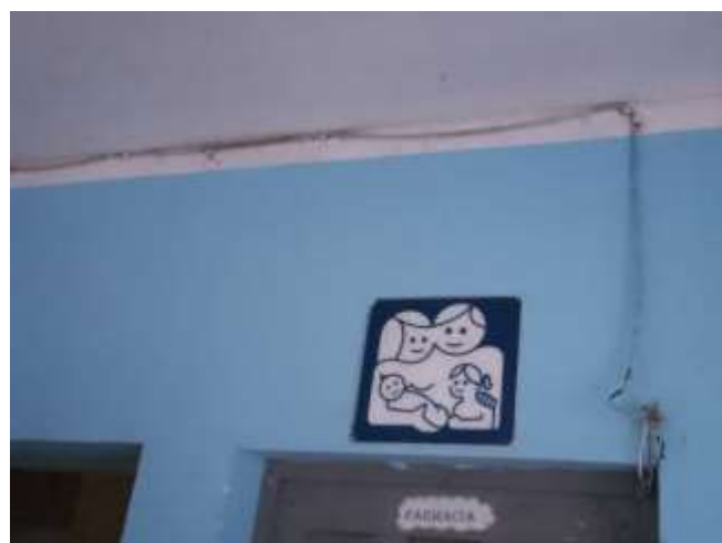
Vista del sistema de cableado incorrecto. Se propone la reinstalación del sistema eléctrico con carriles. Residencia
