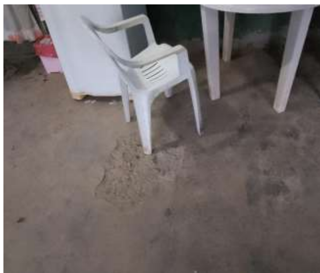
Vista del piso de concreto erosionado, se plantea resane. Ambiente de residencia.
