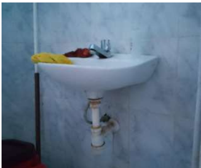
Vista que detalla el acceso de lava mano, tubo de desfogue. Se plantea cambio de los accesorios grifo y tubería. Ambiente baño de medicina
