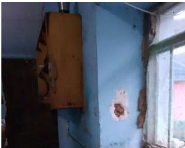
Vista que detalla faltante del material de estuco. Se propone restitucion del material faltante y repintado. Ambiente de residencia
