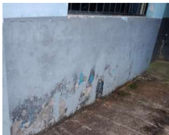
Vista que detalla el proceso de exfoliación de las capas de pintura a nivel de zócalo, ocasionado por la humedad y lluvias. Se plantea repintado.
