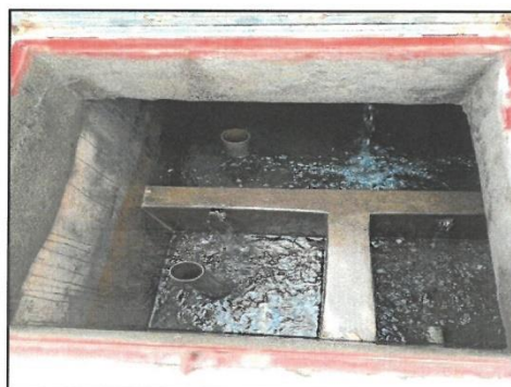
IMAGEN N° 08,09 – CAMARA DISTRIBUIDORA DE CAUDALES
