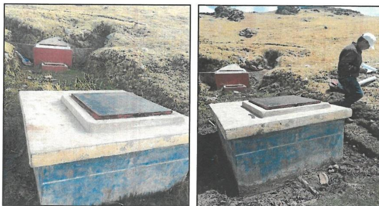
IMAGEN N° 05, 06 – CAMARA DISTRIBUIDORA DE CAUDALES
