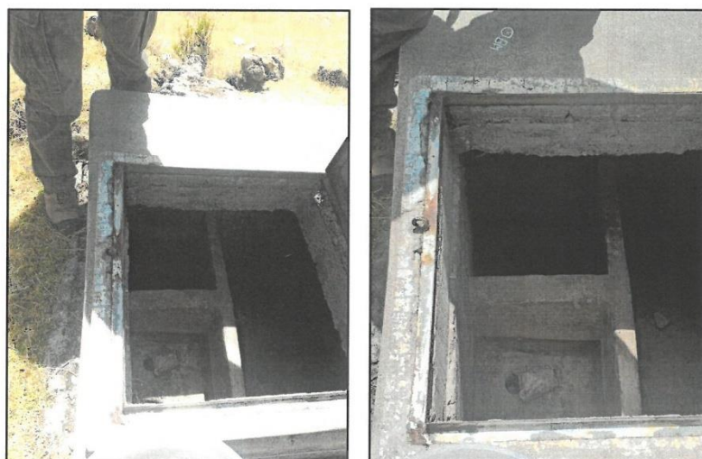
IMAGEN 08,09 – CAMARA DISTRIBUIDORA DE CAUDALES
