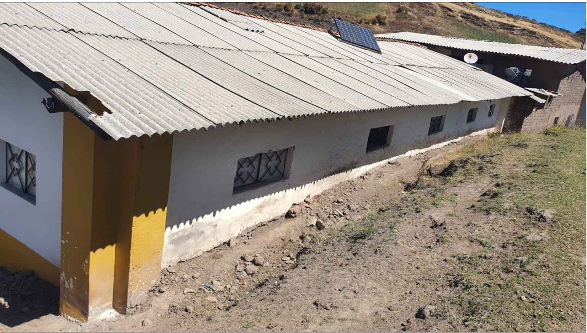
IMAGEN N°2: SE VISUALIZA LA COBERTURA DE FIBROCEMENTO EN MAL ESTADO CON FISURAS
