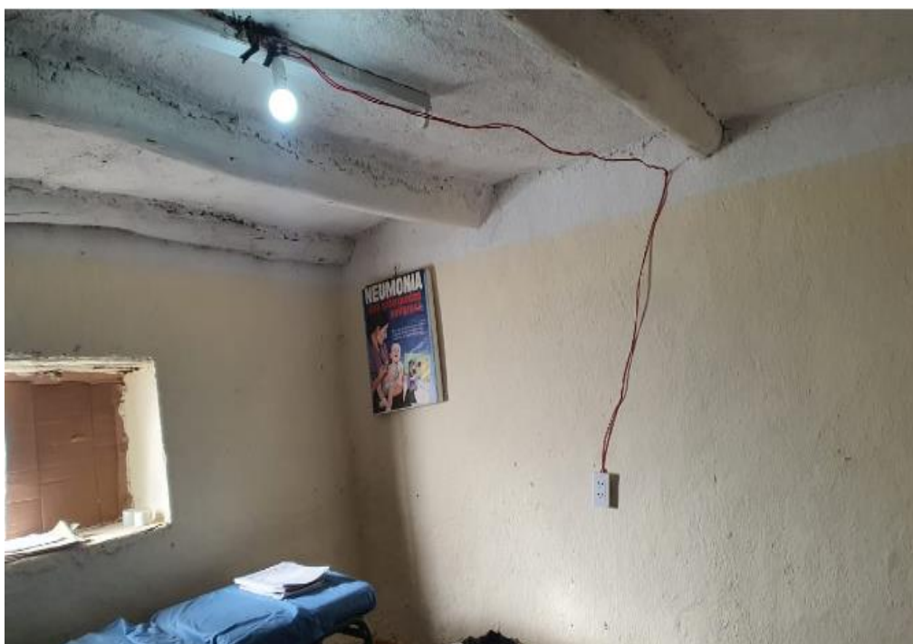
Foto 13. Se observa las conexiones de cable expuestas e instalaciones inadecuadas y una iluminación de intensidad baja para el ambiente.
