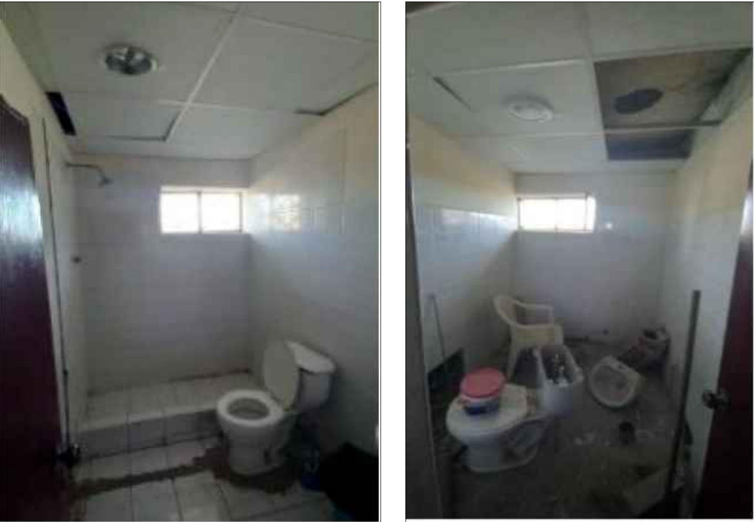
IMAGEN N°2: SE VISUALIZA LOS SERVICIO HIGIENICOS EN MAL ESTADO , INODOROS DETERIORADOS, FALSO CIELORRASO EN MAL ESTADO,
