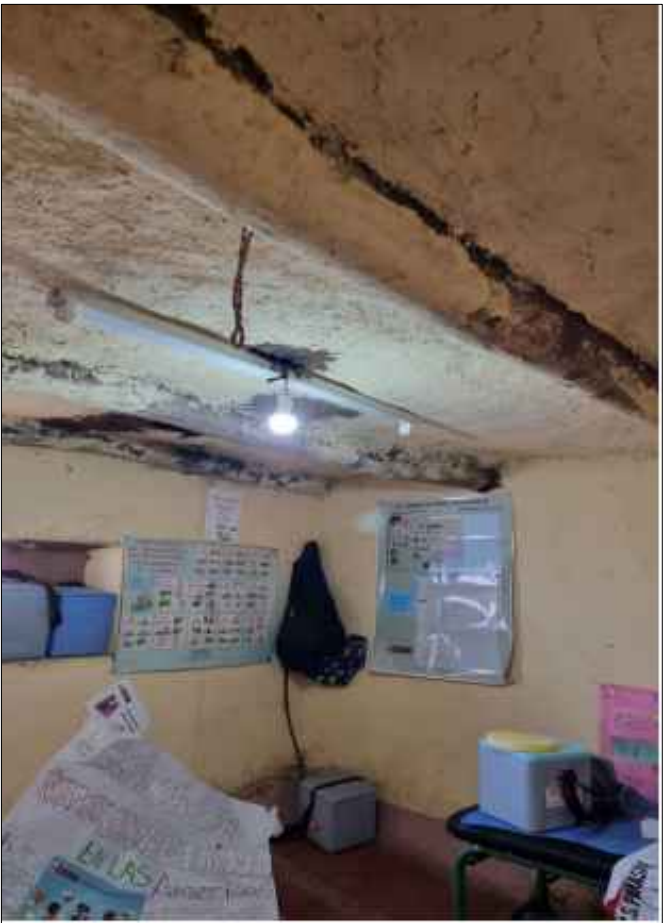
IMAGEN N°5: SE VISUALIZA EL FALSO CIELORRASO EN MAL ESTADO.
