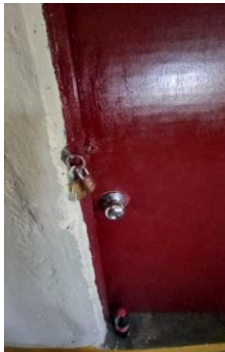
Foto 18. Se observa chapas de puerta en mal estado
