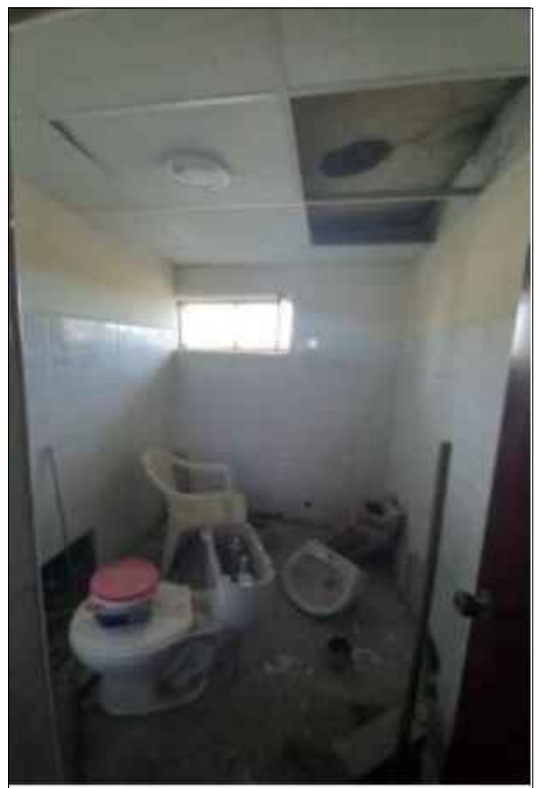
IMAGEN N°4: SE VISUALIZA LOS SERVICIO HIGIENICOS EN MAL ESTADO , INODOROS DETERIORADOS, FALSO CIELORRASO EN MAL ESTADO,
