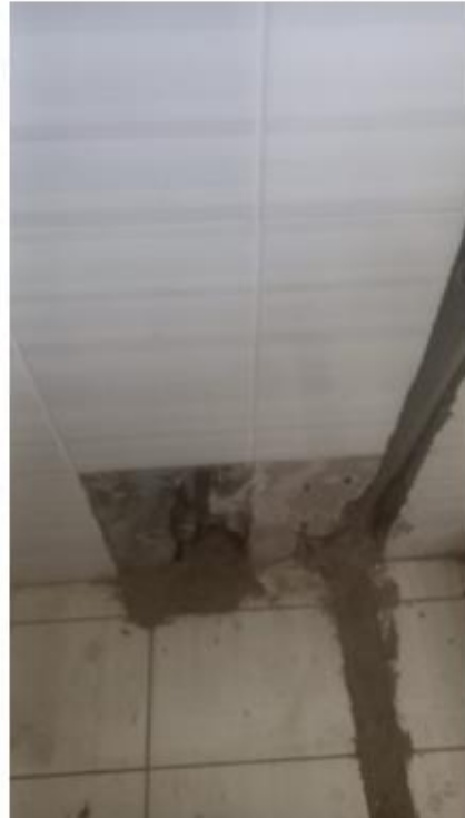
Foto 19. Se observa que las redes sanitarias expuestas y en mal estado
