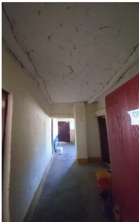
Foto 06. Se observa en mal estado cielo raso existente.
