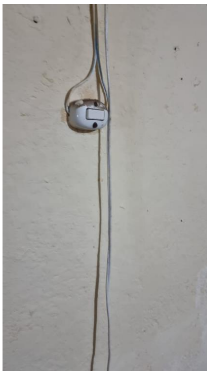
Foto 14. Se observa las conexiones de cable expuestas e instalaciones inadecuadas
