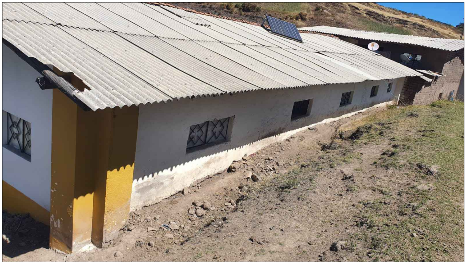
IMAGEN N° 4 : SE VISUALIZA AUSENCIA DE CANALETA PLUVIAL
