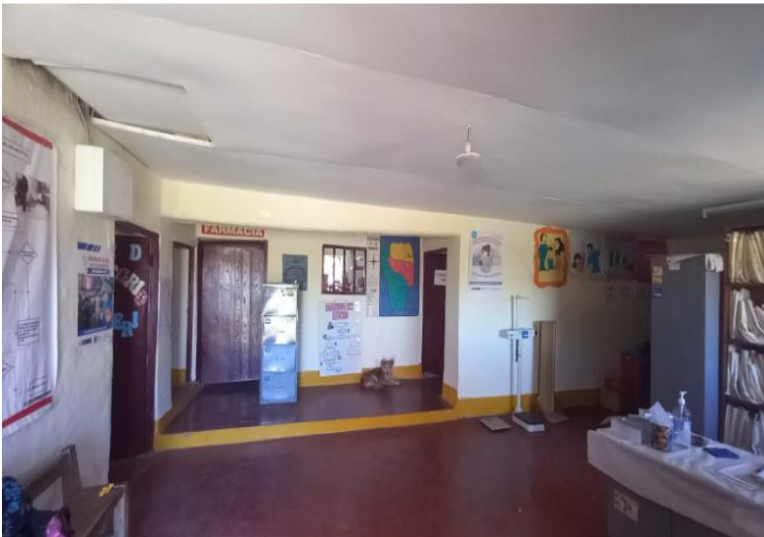
Foto 05. Se observa en mal estado cielo raso existente
