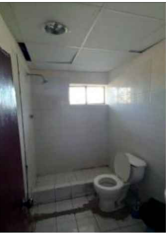
IMAGEN N°4: SE VISUALIZA LOS SERVICIO HIGIENICOS EN MAL ESTADO , INODOROS DETERIORADOS, FALSO CIELORRASO EN MAL ESTADO,
