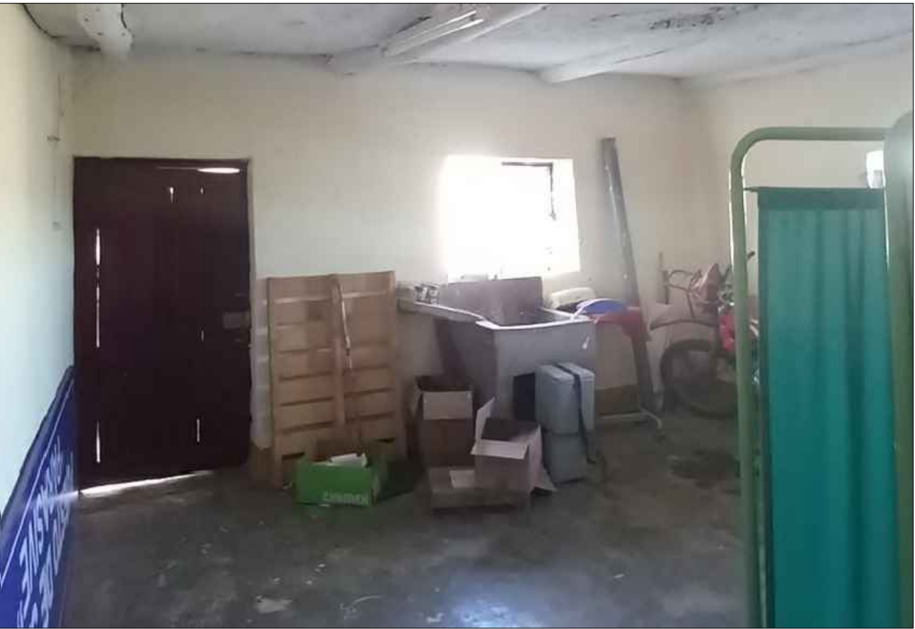
IMAGEN N°1: SE VISUALIZA EL AMBIENTE DE ALMACEN LA PUERTA EXTERIOR DETERIORADA, PISO DE CEMENTO PULIDO EN MAL ESTADO, VENTANA FISURADO
