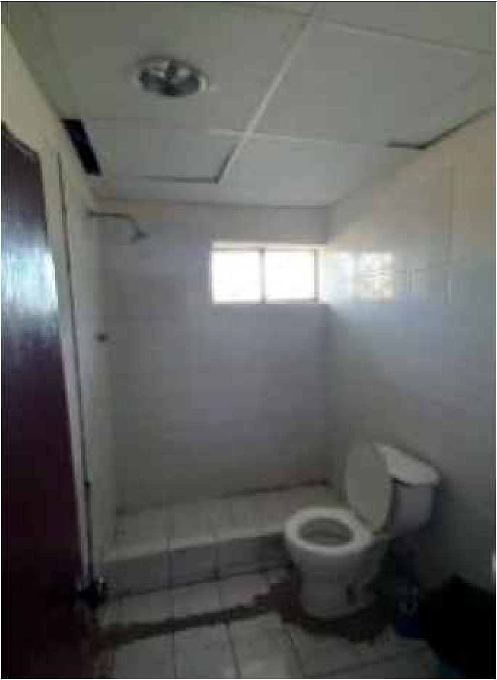
IMAGEN N° 2 Y 3 : SE VISUALIZA EN LOS INODOROS Y LAVATORIOS EN MAL ESTADO, NO TIENE PISO DE CERAMICA
