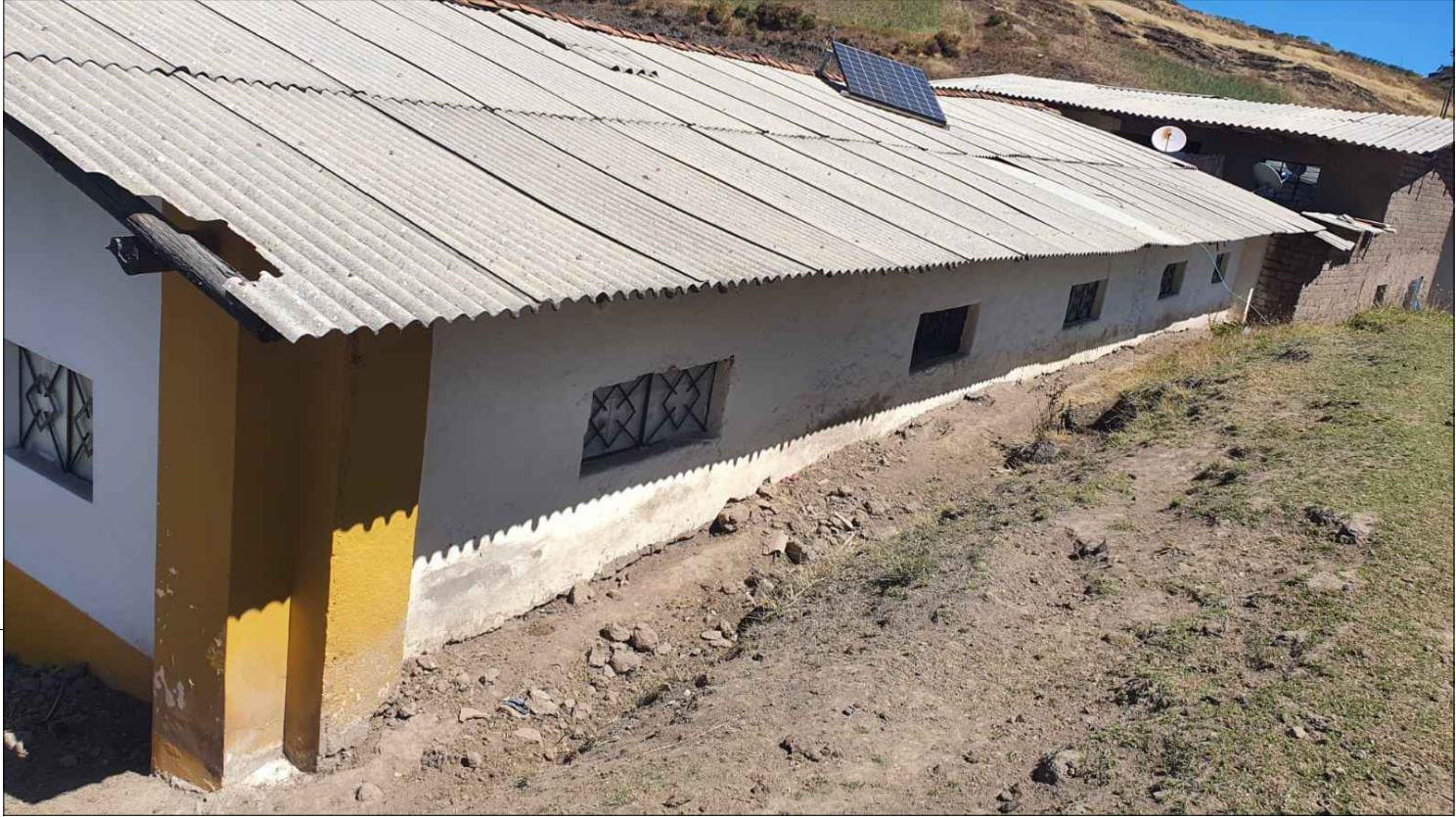
IMAGEN N°1: NO CUENTA CON CANALETA PLUVIAL
