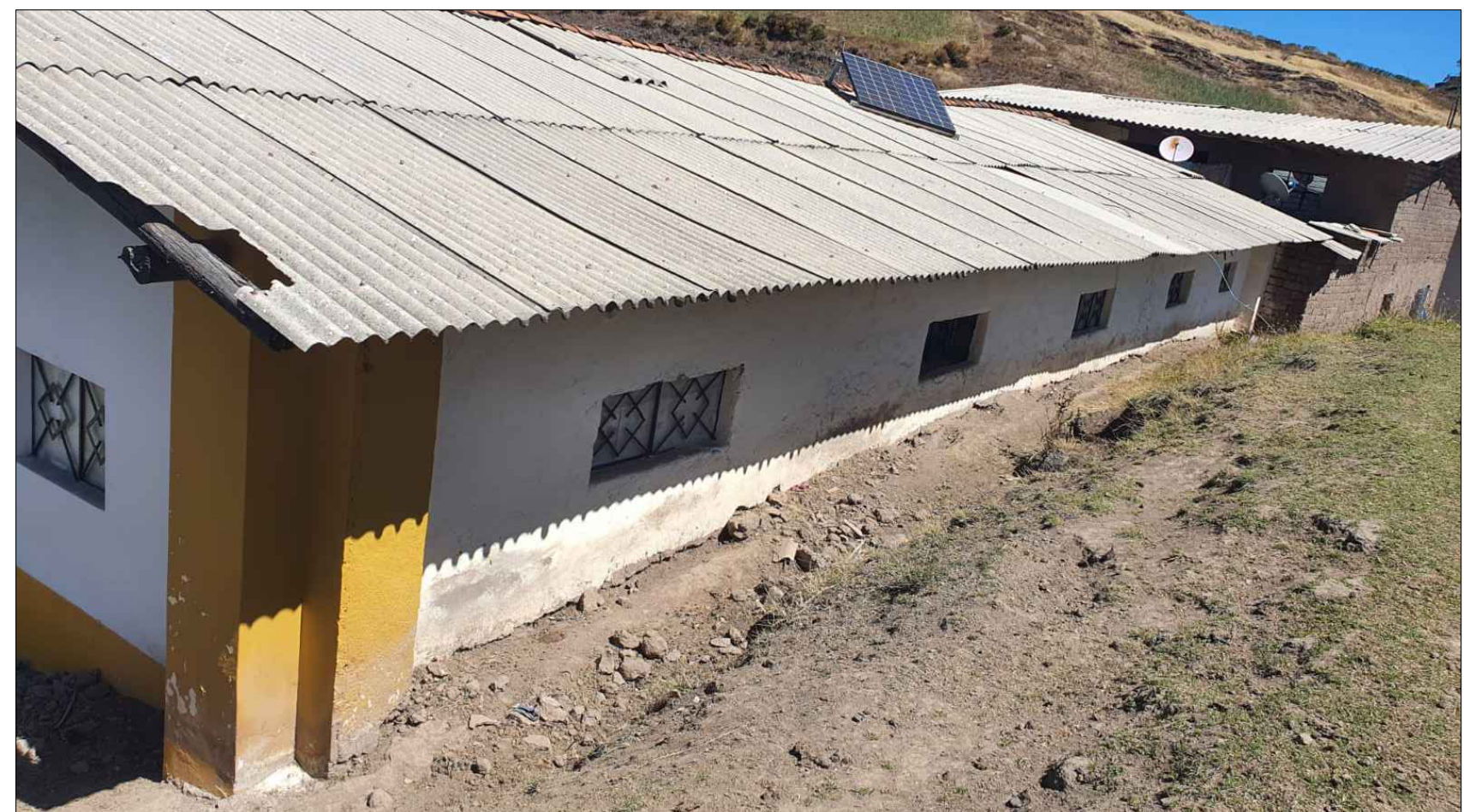
CAMBIO DE COBERTURA DE FIBROCEMENTO POR UNA DE ALUZINC TR-4 X6 DE 0.30MM
