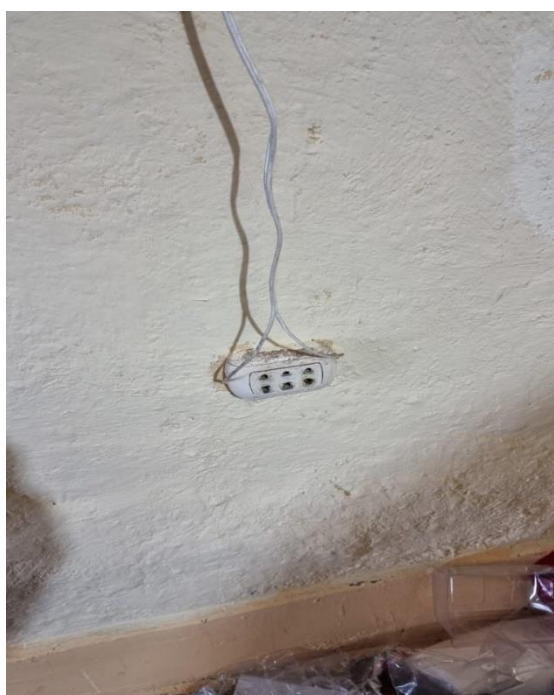
Foto 14. Se observa las conexiones de cable expuestas e instalaciones inadecuadas
