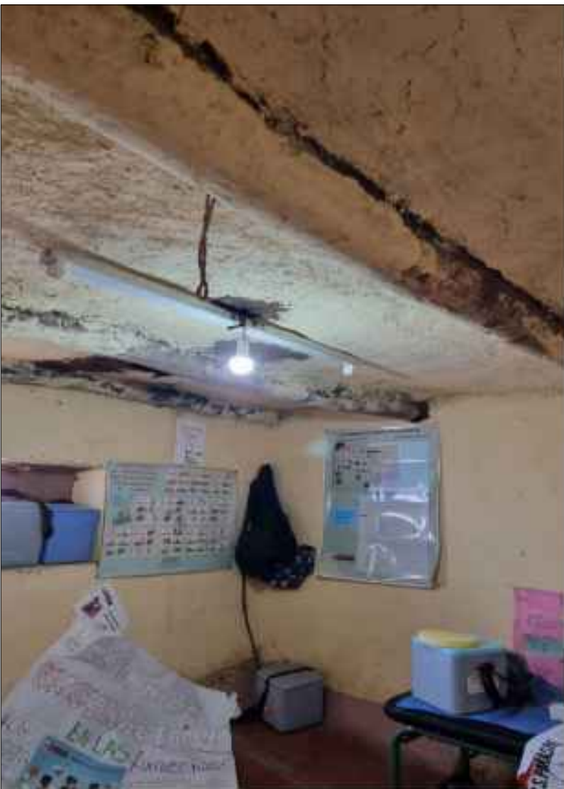
IMAGEN N°3 Y 4: SE VISUALIZA LA ILUMINACION DEL BAÑO EN MAL ESTADO Y UN FOCO DE Poca ILUMINACION PARA EL AMBIENTE DE CONSULTORIO MEDICO
