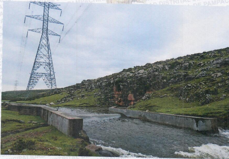
Vista Fotográfica de la CAPTACION existente en el rio Toracorrall, con caudal garantizado para el Planteamiento Hidráulico del Proyecto.
