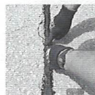
6.2. Introducir cordón de mástico en fisura. (Parte 2)
