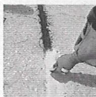
9. Recebar con arena de sílice la superficie.
