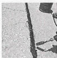
7. Calentar con soplete ligeramente el cordón.
