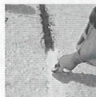
9. Recebar con arena de sílice la superficie.
