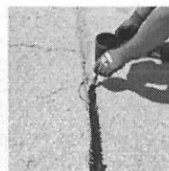
5. Imprimir zona de la fisura.
