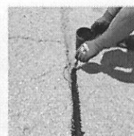
5. Imprimir zona de la fisura.
