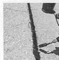
7. Calentar con soplete ligeramente el cordón.
