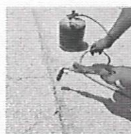
4. Calentar fisura con soplete.
