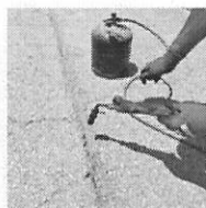
4. Calentar fisura con soplete.
