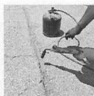
4. Calentar fisura con soplete.
