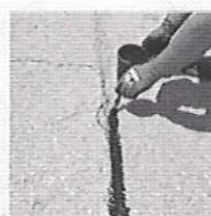
5. Imprimir zona de la fisura.
