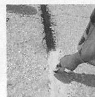
9. Recebar con arena de sílice la superficie.
