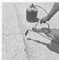
4. Calentar fisura con soplete.
