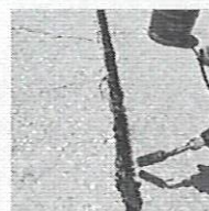
7. Calentar con soplete ligeramente el cordón.
