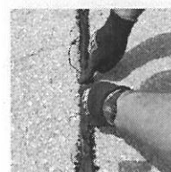
6.2. Introducir cordón de mástico en fisura. (Parte 2)
