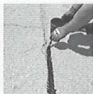
5. Imprimir zona de la fisura.
