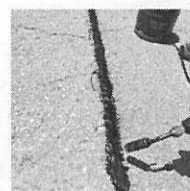
7. Calentar con soplete ligeramente el cordón.
