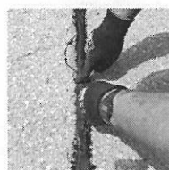
6.2. Introducir cordón de mástico en fisura. (Parte 2)
