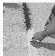
9. Recebar con arena de sílice la superficie.
