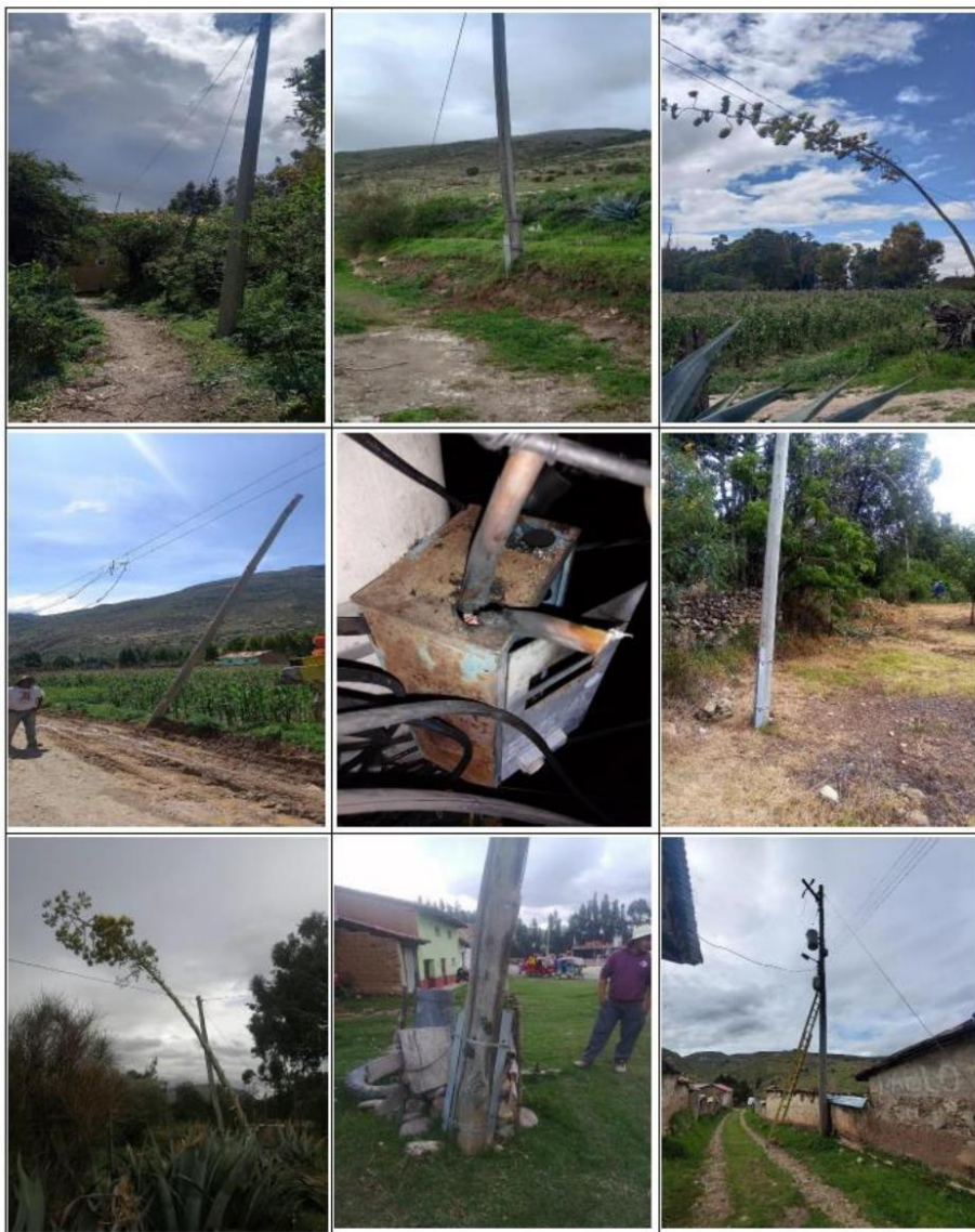
Fig. N° 06: Poste de madera de media tensión deteriorada
