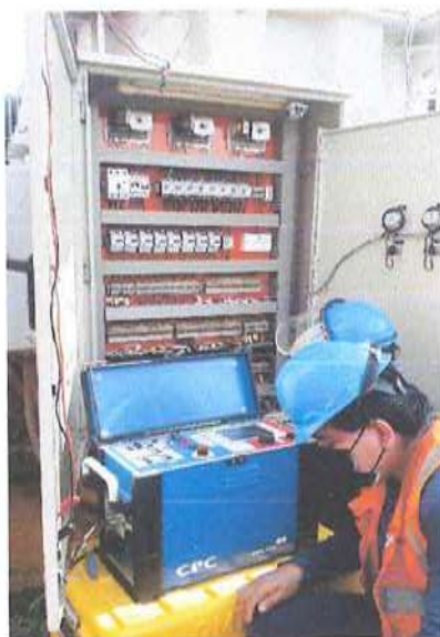
Ilustración 13.- Pruebas en transformadores de corriente
