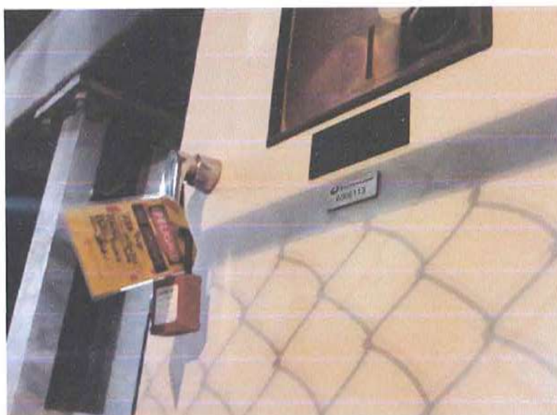
Ilustración 3.- Bloqueo y etiquetado de interruptor de 60 Kv
