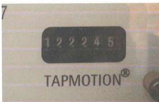
Ilustración 5.- Número de conmutación en el OLTC
