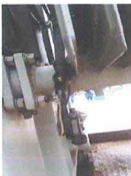
Ilustración 8.- Conductores de ventiladores expuestos
