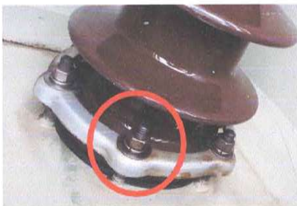
Ilustración 6.- Fuga en el aislador fase W, lado de 10 Kv
