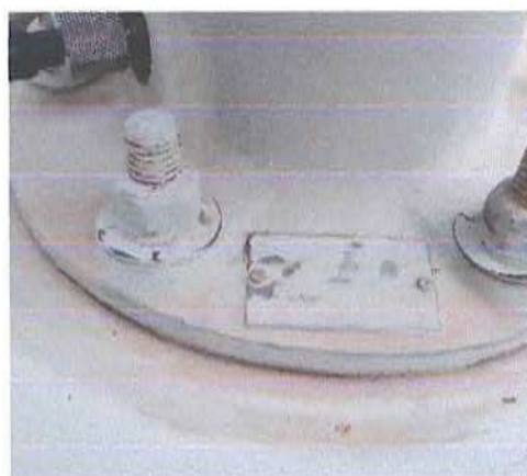
Ilustración 7.- Placa de características del aislador pintada
