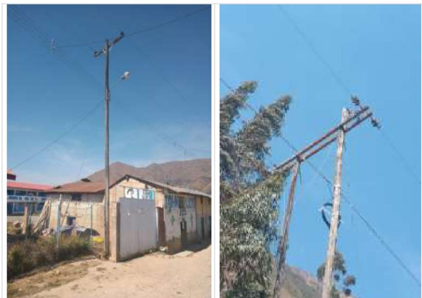
Estructuras en el AMT A4507, requieren su mejoramiento, por cumplir su vida útil o incumplimiento DMS
