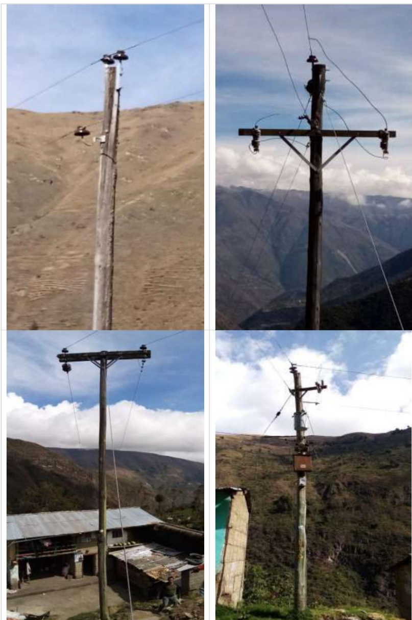
Estructuras en el AMT A4508, requieren su mejoramiento, por cumplir vida útil o incumplimiento de DMS
