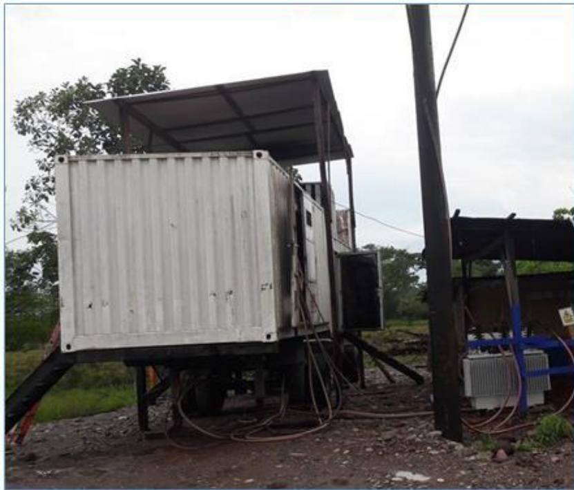
Vista del container del Grupo Electrogenerador CAT 3412 de la CT Codo del Pozuzo
