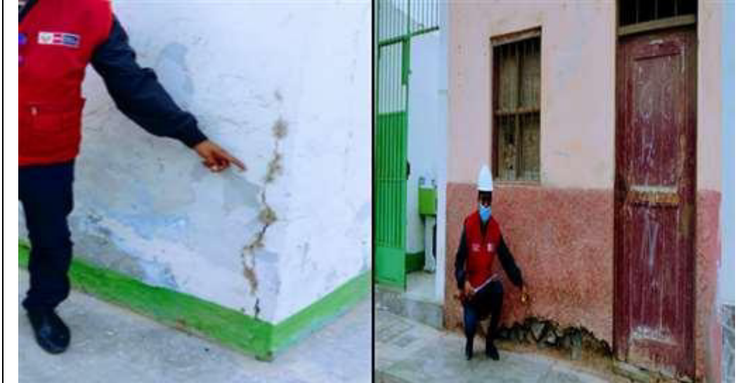
Fotografía N° 02: Se muestra la presencia de grietas en la columna del aula y debilitación de la base de construcción del almacén con vista a la calle dichas infraestructuras ejecutadas por autoconstrucción.
