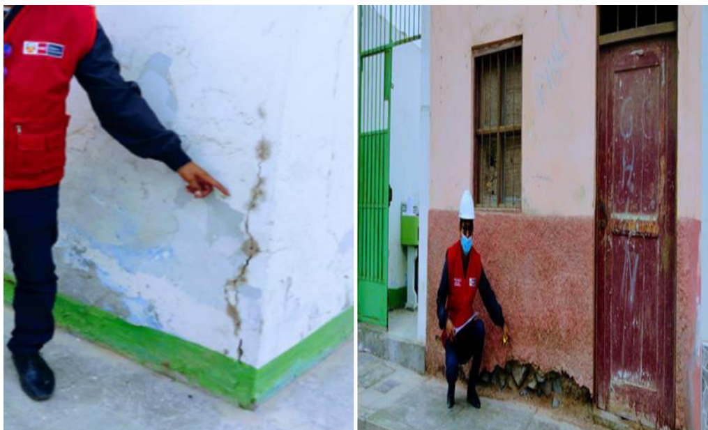
Fotografía N° 02: Se muestra la presencia de grietas en la columna del aula 1 y debilitación de la base de construcción del almacén con vista a la calle.
