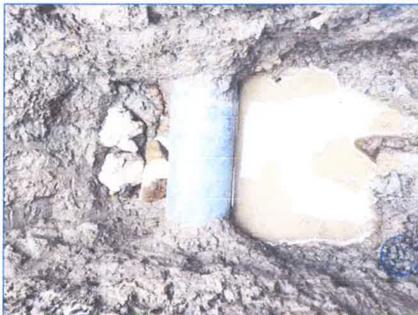
Imagen 1: Relleno inadecuado que afectara la funcionalidad y comportamiento de la tubería PVC.
