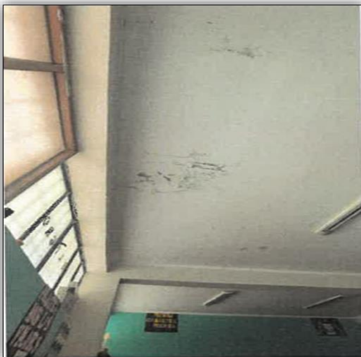
Vista fotográfica N° 10: Vista de filtraciones
