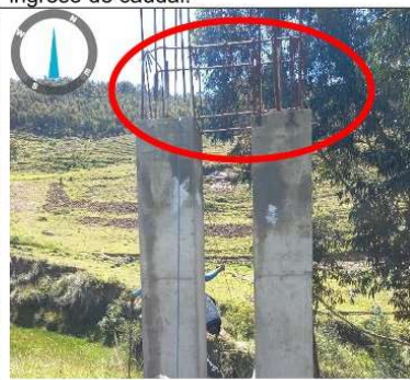
Fotografía N°04: Pases Aéreo falta colocar accesorios y tubería HDPE, acero utilizado está expuesto al medio y se encuentra oxidado.
