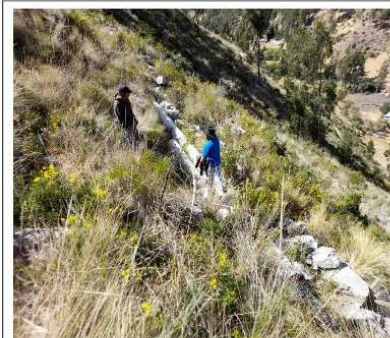
Fotografía N°09: Tubería PVC expuesta al medio ambiente, sin empalmar.
