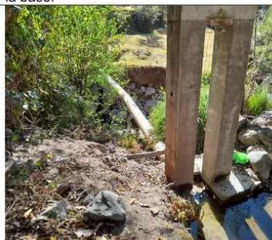
Fotografía N°03: Pases Aéreos de diferente Longitudes se encuentran inconclusa solamente con zapatas y columnas.
