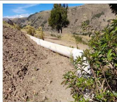
Fotografía N°10: Tubería PVC expuesta al medio ambiente.
