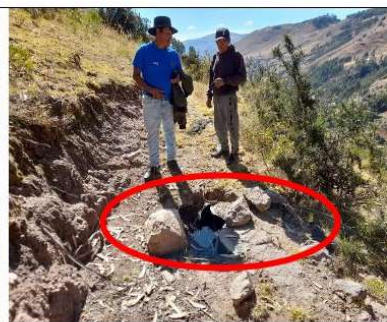
Fotografía N°08: Tubería PVC rota.
