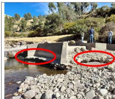
Fotografía N°01: Inicio Km 0+000, Bocatoma tipo Barraje se encuentra deteriorada por presentar socavación en la base.
