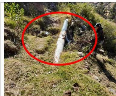
Fotografía N°07: Tubería PVC rota, expuesta al medio ambiente.
