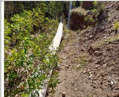
Fotografía N°11: Tubería PVC expuesta al medio ambiente.
