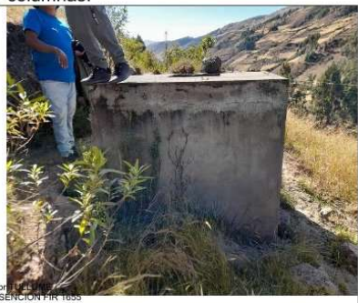
Fotografía N°03: Pases Aéreos de diferente Longitudes se encuentran inconclusa solamente con zapatas y columnas.
