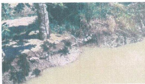
Toma Directa. Los usuarios aperturan el canal y luego del riego la sellan con material propio.
