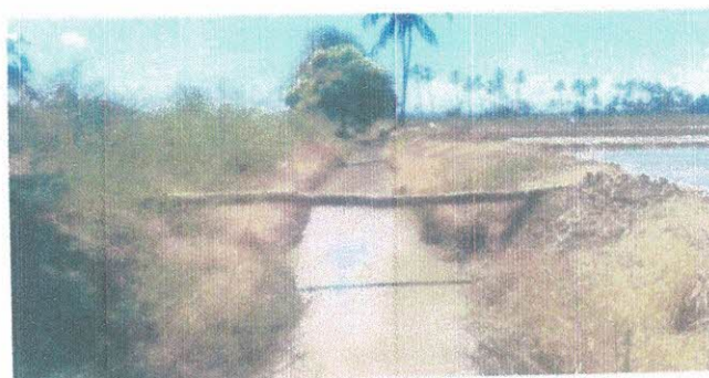
Cruces Peatonales construidos por los usuarios con troncos de árboles que utilizan para el transporte al hombro de insumos o extracción de la cosecha.
