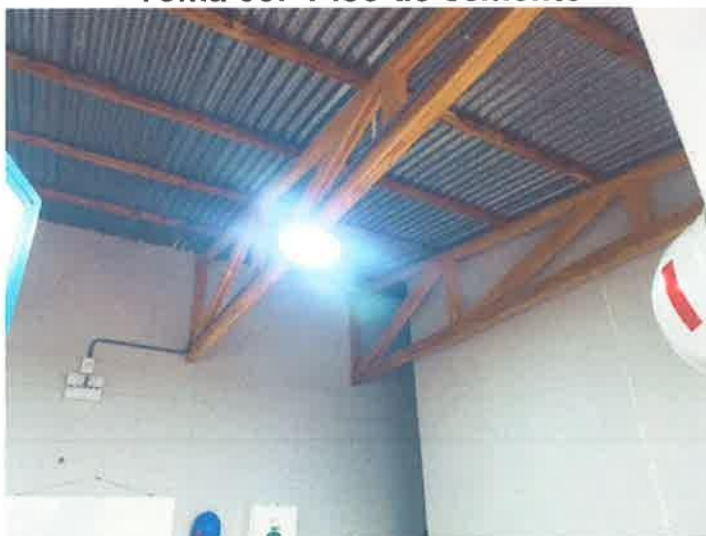
Toma 06: Techo de calamina sin cielo raso -almacen
