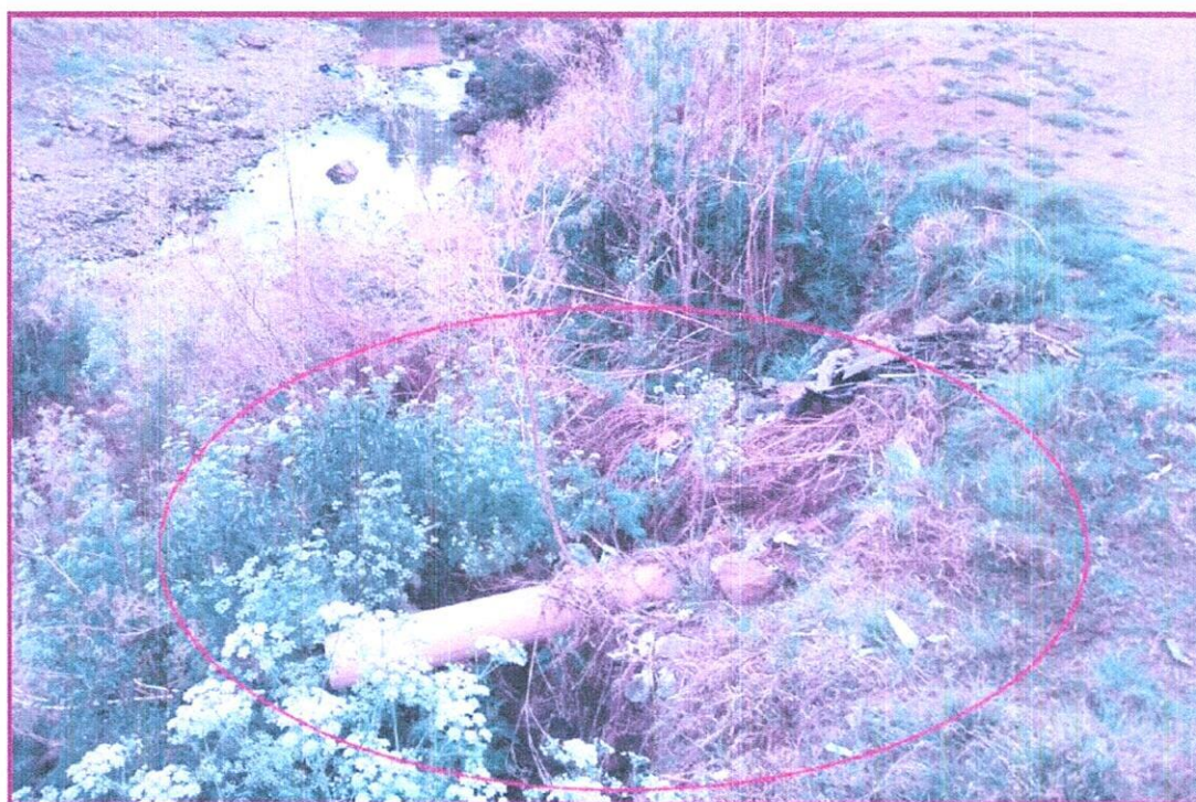
Figura 6. Sistema de alcantarillado en desuso.
