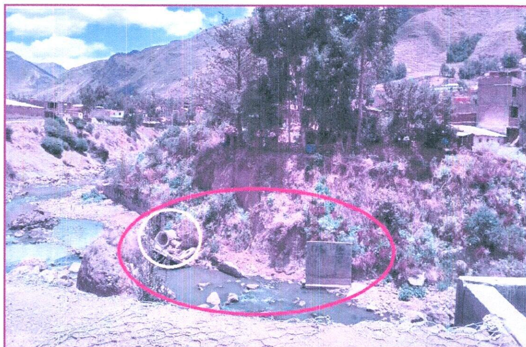
Figura 8. Buzones inoperativos a causa de la socavación en la ribera del río Ichu.
