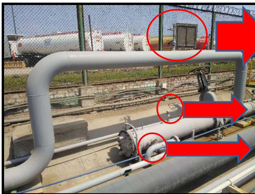
Esquema referencial de instalación de purga o venteo en tramo terrestre para LSN1 y LSN2
