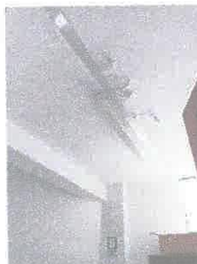
Imagen 06: descascaramiento de pintura en cielos rasos.
