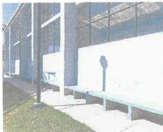
Imagen 02: Se visualiza zonas salitrosas, se deberá realizar tratamiento anti salitre.
