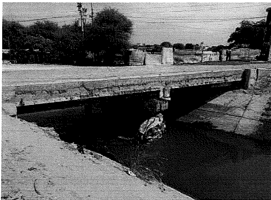
FOTO N° 02 PASARELA KM 37 EN MAL ESTADO SU SUB ESTRUCTURA Y SUPERESTRUCTURA
