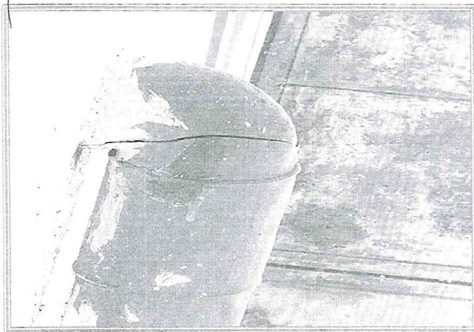
IMAGEN N°14: Tuberías rotas y mal estado. FECHA: Abril
