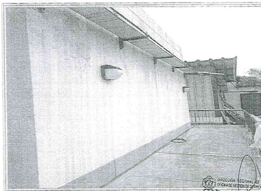
IMAGEN N°4: La pintura de los muros y contra zócalos presentan decoloración y desprendimiento de pintura. FECHA: Abril
