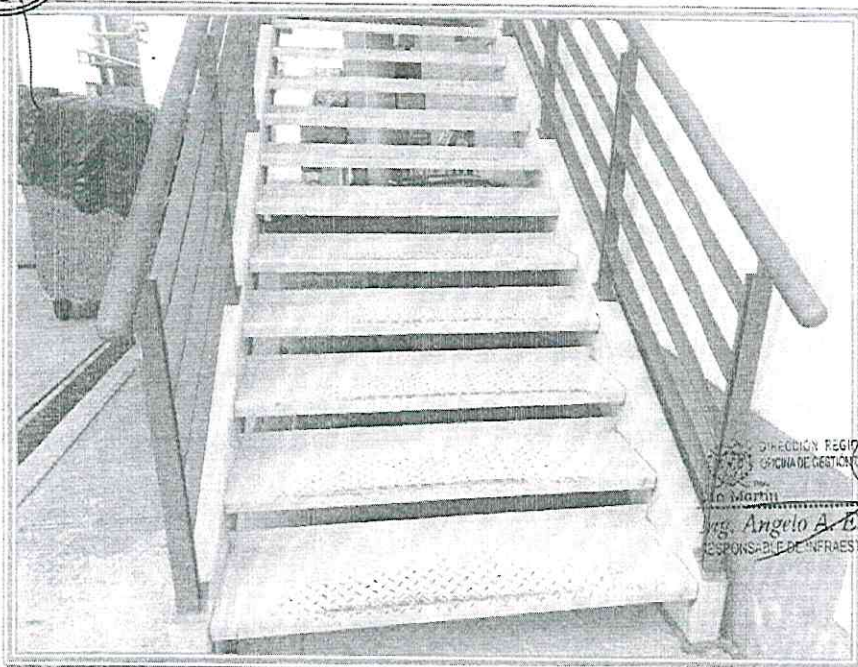
IMAGEN N°10: Pintura de escaleras metálicas, se encuentran desgastadas. FECHA: Abril
