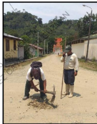
Imagen: Tapa de buzón enterrado con material de afirmado. (Sector San Isidro)
