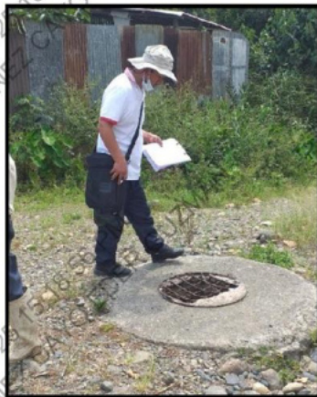
Imagen: Tapa de buzón en mal estado. (Sector San Isidro)
