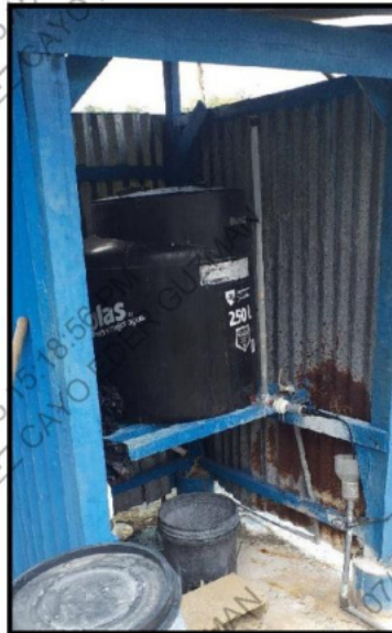
Imagen: Sistema de Cloración artesanal (Reservorio 1)
