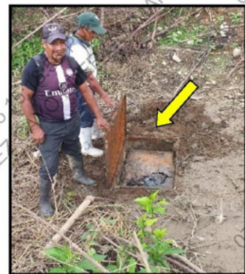
Imagen: Tanque séptico colmatado de lodo. (todos los tanques sépticos se encuentran en esta situación)
