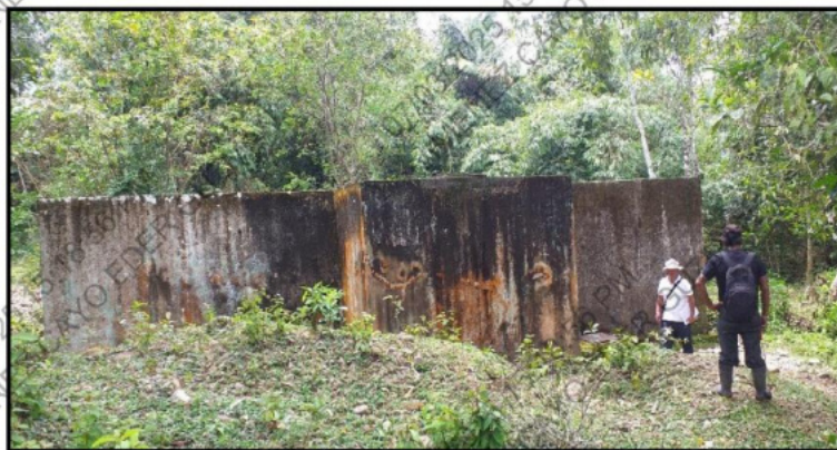
Imagen: Planta de tratamiento de agua, Filtro lento de arena en mal estado.
