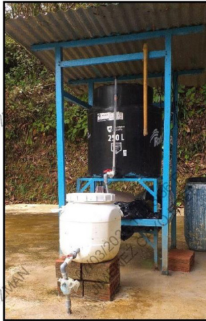
Imagen: Sistema de Cloración Artesanal (Reservorio 3)
