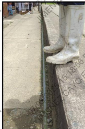
Imagen: Tubería de agua expuesta.
