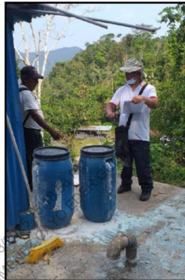
Imagen: Sistema de Cloración artesanal (Reservorio 1)
