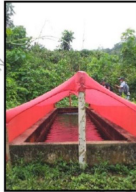
Imagen: Sedimentador de concreto armado.
