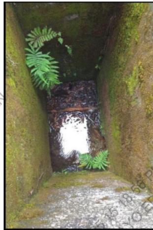
Imagen: Compartimiento de limpieza sin mantenimiento
