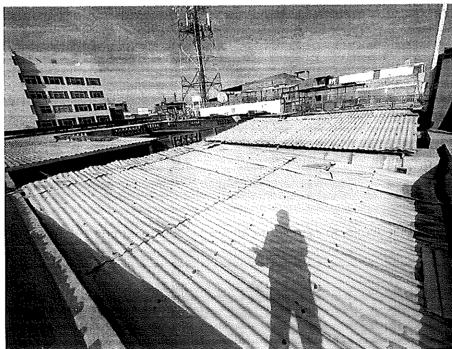
Techos inclinados en mal estado, presenta problemas de evacuación pluvial
