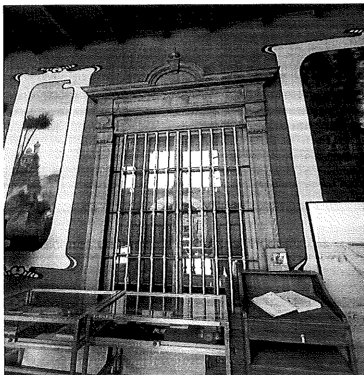
Protectores de fierro deteriorados, vidrios rotos
