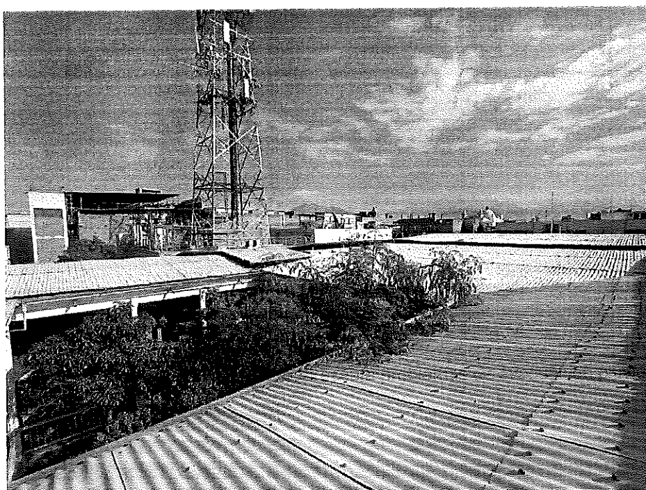
Techos inclinados en mal estado, presenta problemas de evacuación pluvial
