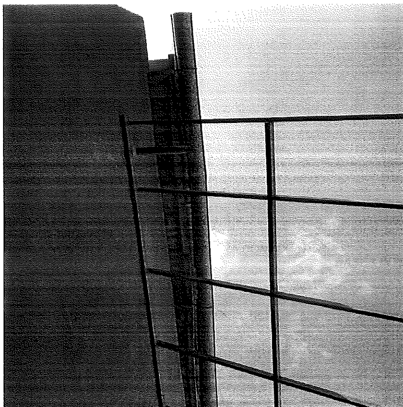
Canaletas de aguas pluviales deterioradas y oxidadas
