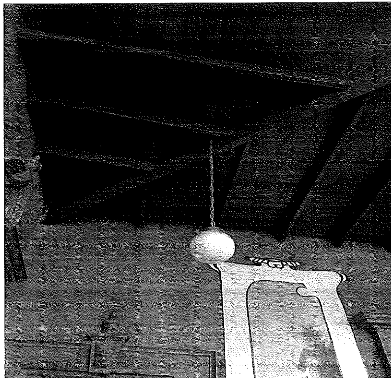
Luminarias deterioradas por falta de mantenimiento.
