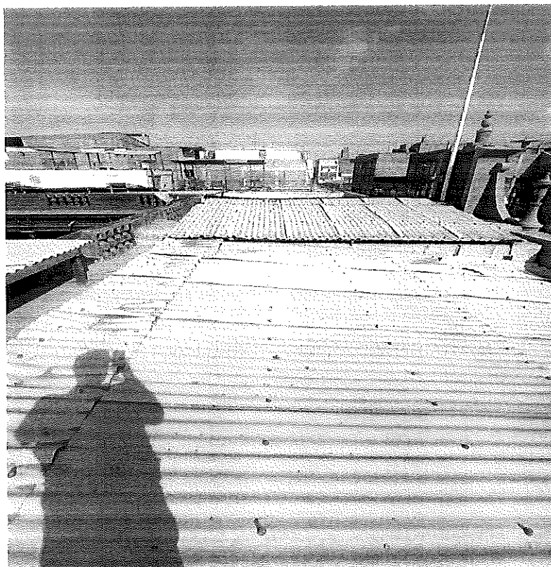
Techos inclinados en mal estado, presenta problemas de evacuación pluvial
