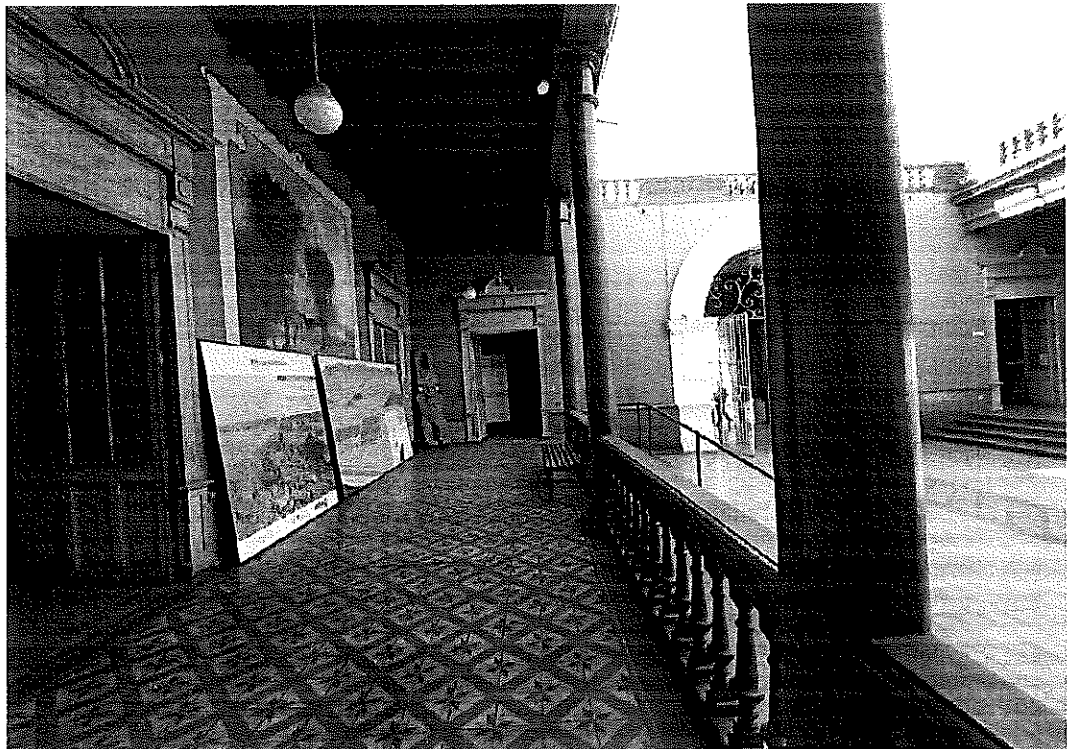
Marcos de madera en vanos y puertas deteriorados por el paso del tiempo
