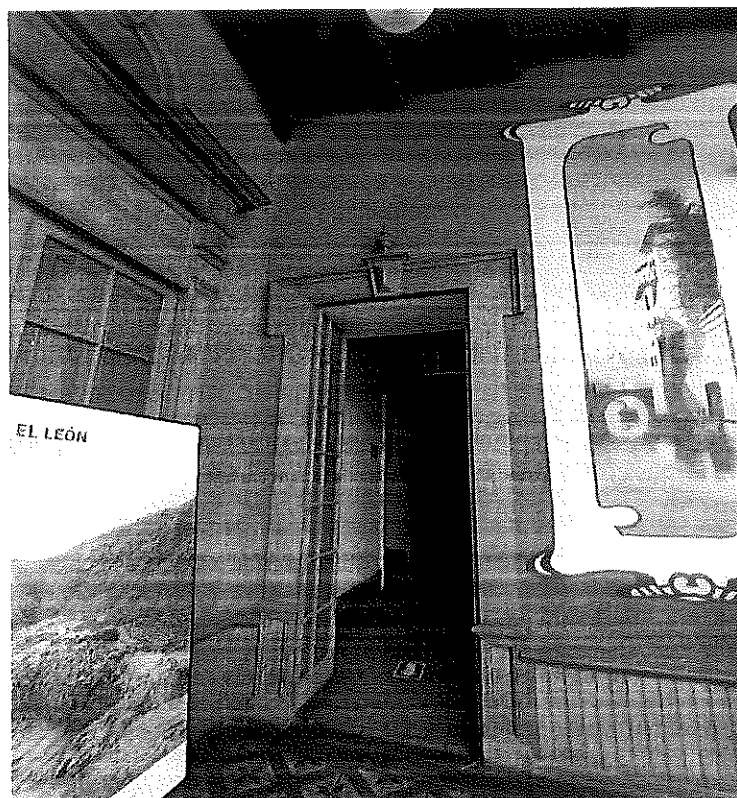
Marcos de madera en vanos y puertas deteriorados por el paso del tiempo
