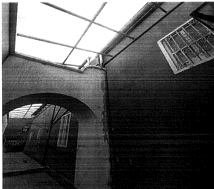
Caídas de aguas residuales deterioradas
