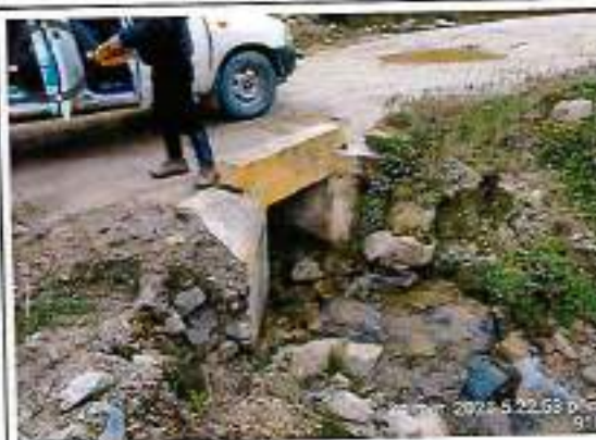
Foto 42: Alcantarilla tipo Marco - Progresiva 50+000
