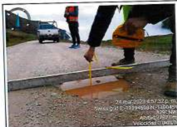
Foto 33: Espesor de afirmado - Progresiva 48+520
