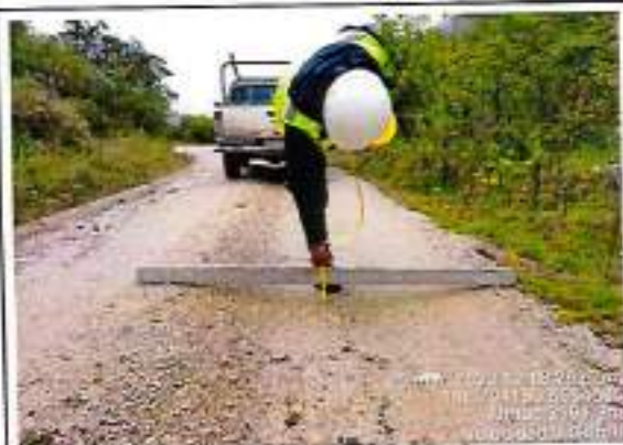
Foto 105: Ahuellamiento Erosion y Baches - Progresiva km 59+000
