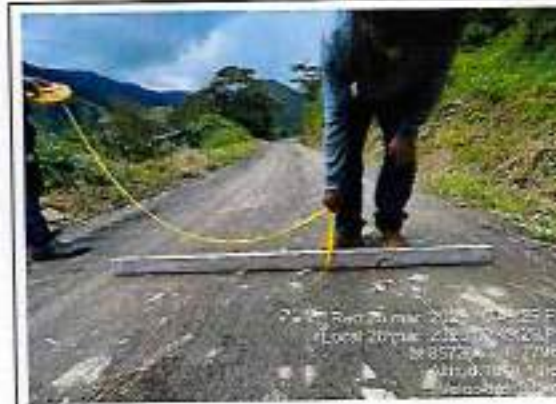
Foto 278: Erosión ahuecamiento y baches - progresiva km 96+000
