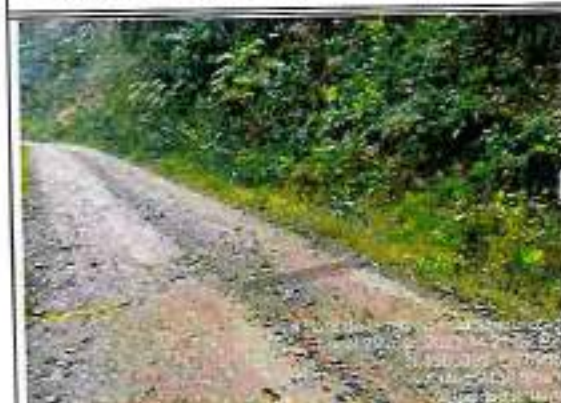
Foto 173: Ahuellamiento baches y erosión - progresiva 72+000
