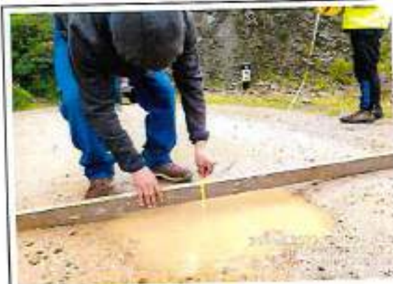
Foto 135: Espesor de afirmado - progresiva km 64+180
