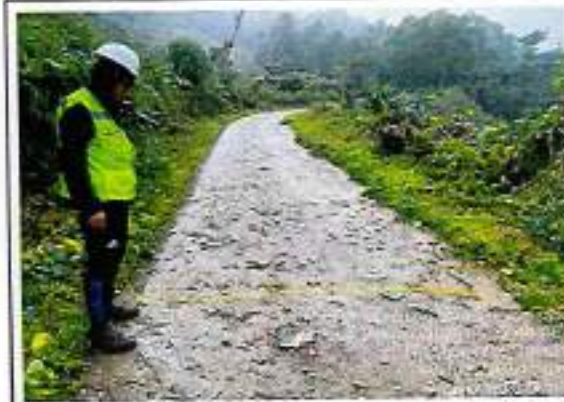
Foto 194: Ahuellamiento erosión, baches y ancho de vía - progresiva km 77+500
