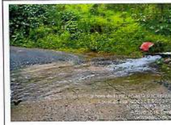
Foto 262: badén de concreto armado - progresiva km 92+900
