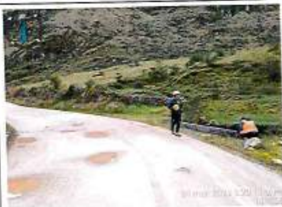
Foto 41: Ahuellamiento, Baches y Erosion - Progresiva 49+795
