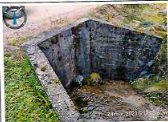
Foto 39: Alcantarilla TMC 24\"/>
