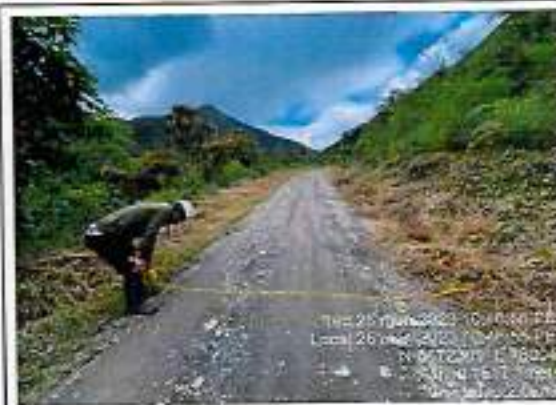
Foto 276: Ancho de vía, Erosión ahuecamiento y baches - progresiva 95+500
