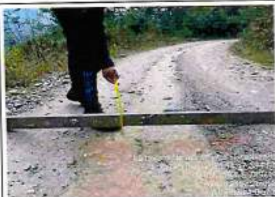
Foto 173: Ahuellamiento baches y erosión - progresiva 72+000
