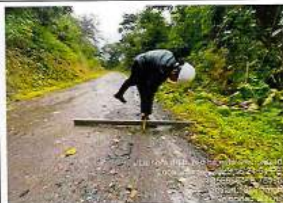
Foto 218: Espesor de afirmado - progresiva km 81+740
