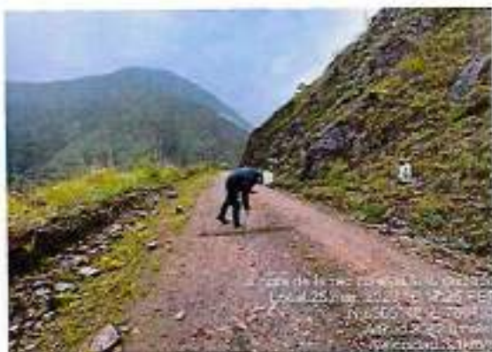
Foto 215: Ahuellamiento erosión y baches - progresiva km 81+320
