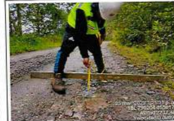
Foto 154: Ahuellamiento Erosion y baches - progresiva km 68+500
