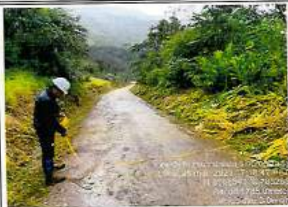
Foto 241: erosión Amueblamiento y Baches - progresiva km 87+500
