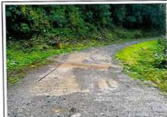
Foto 193: Bache de concreto armado - progresiva 76+680
