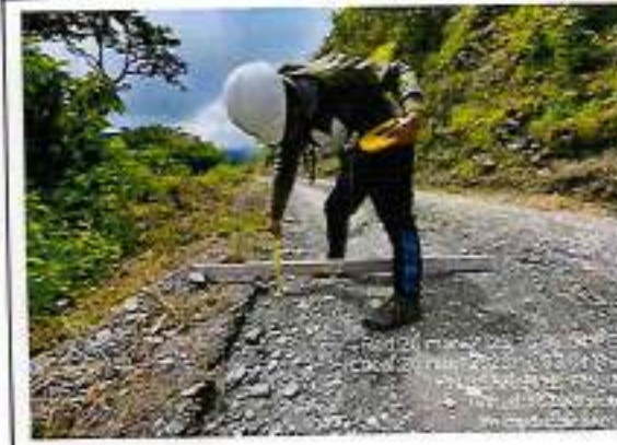
Foto 280: ahuecamiento erosión y baches - progresiva km 96+500
