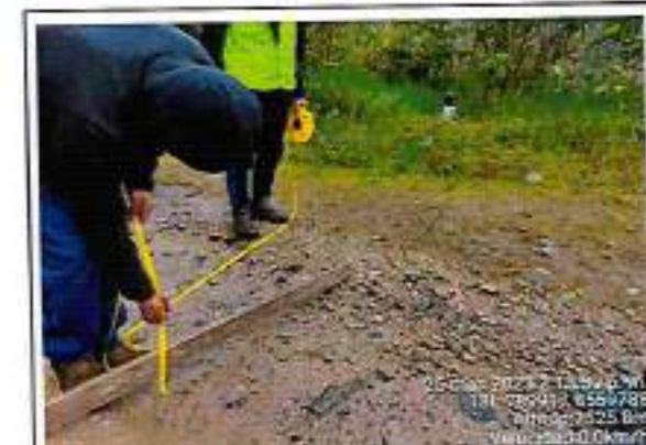
Foto 181: Espesor de afirmado - progresiva 71+666
