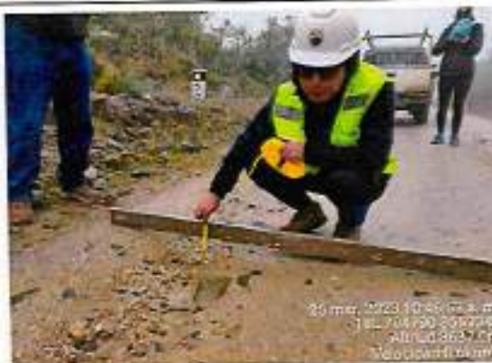
Foto 58: Hito kilométrico 53 y Espesor de afirmado - Progresiva km 52+180
