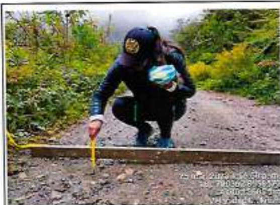
Foto 161: Espesor de afirmado - progresiva km 70+000
