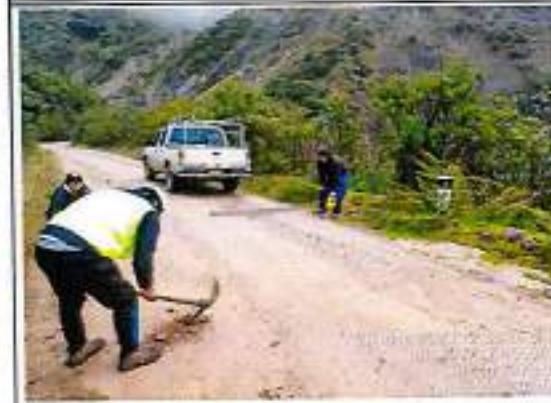
Foto 120: Ahuellamiento erosion y baches - progresiva km 62+340
