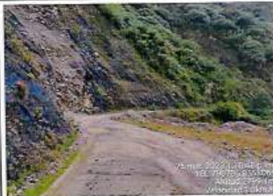
Foto 150: Ahuellamiento erosión y baches - progresiva km 67+500
