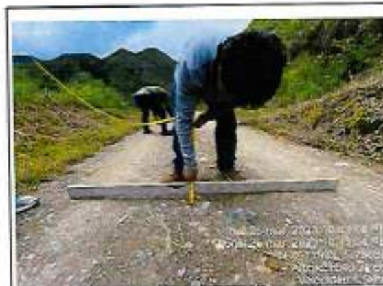
Foto 273: erosion ahuellamiento y baches - progresiva km 95+000
