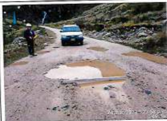
Foto 44: Ahuellamiento, Erosion y Baches - Progresiva km 50+100
