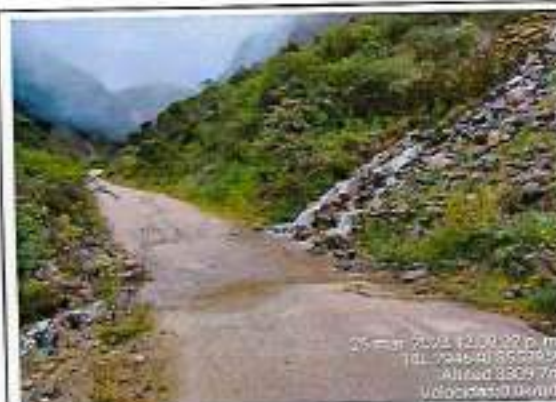
Foto 96: Baden de Concreto Armado - Progresiva km 57+400
