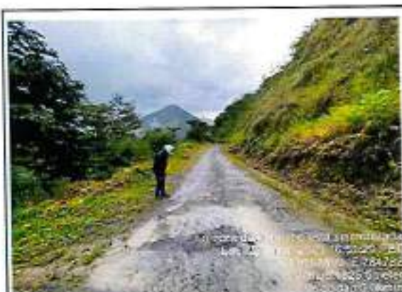
Foto 233: Ancho de vía y amueblamiento erosión y baches - progresiva km 86+500
