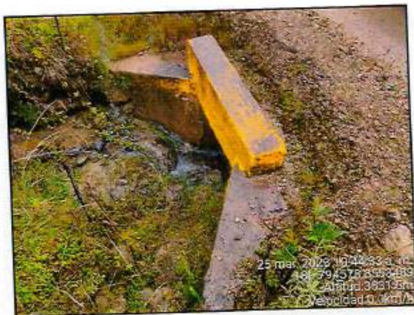
Alcantarilla Colmatada
