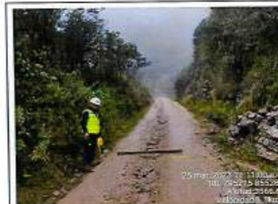
Foto 71: Erosion, Ahuellamiento y baches - Progresiva 53+900
