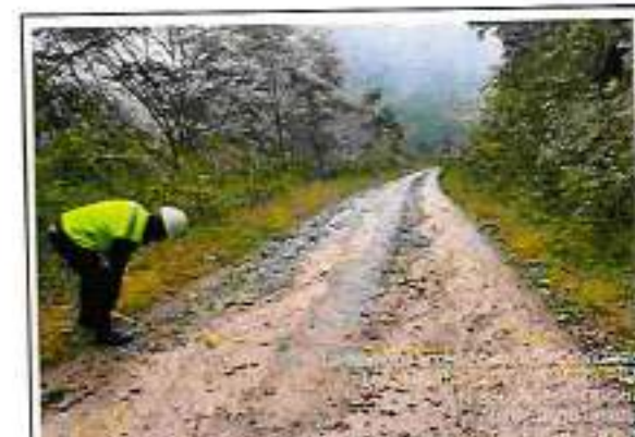
Foto 175: hito kilométrico 75 y Ahuellamiento erosión y baches - progresiva km 72+560
