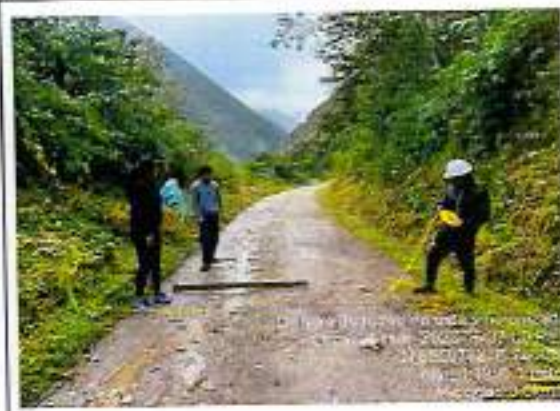
Foto 226: Ahuellamiento erosión y baches - progresiva km 83+500
