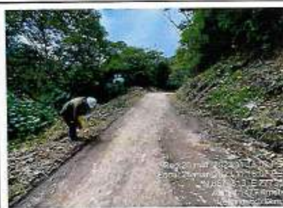
Foto 294: Ancho de vía, Ahuellamiento erosión y baches - progresiva 99+500
