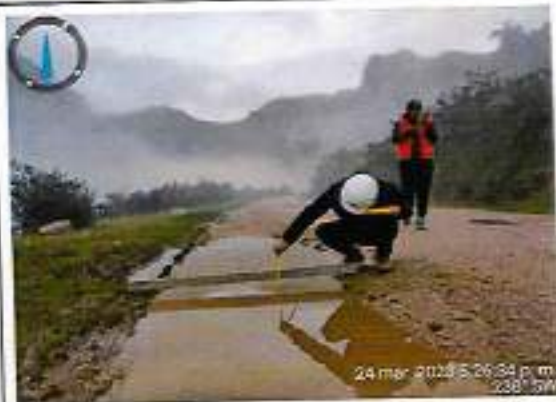
Foto 48: Ahuellamiento, Erosion y Baches - Progresiva 60+350
