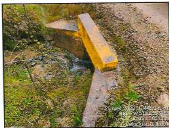
Alcantarilla Colmatada
