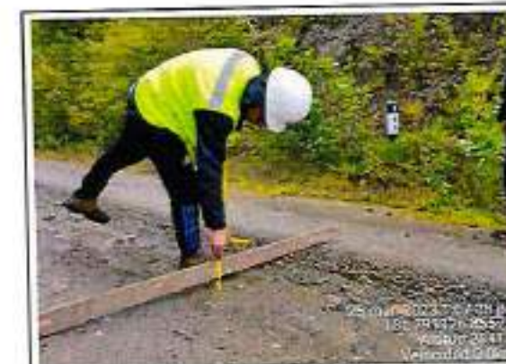
Foto 147: Espesor de afirmado - progresiva km 67+030
