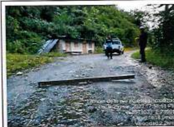
Foto 266: Ahueamiento erosion y baches - progresiva km 93+500
