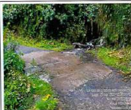
Foto 252: Bedén de concreto armado - progresiva km 90+975
