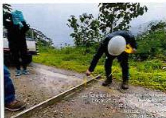
Foto 218: Espesor de afirmado - progresiva km 81+740
