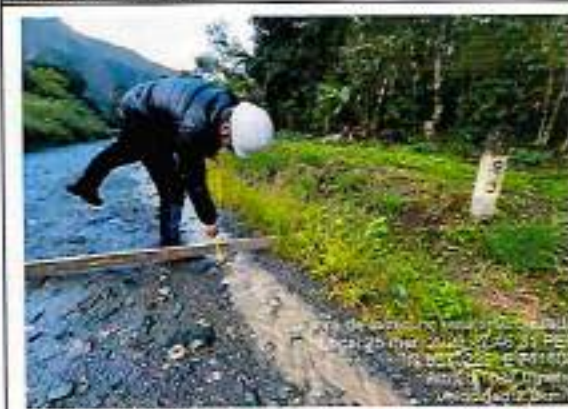
Foto 258: Ancho de vía, erosión ahuellamiento y baches - progresiva km 92+000
