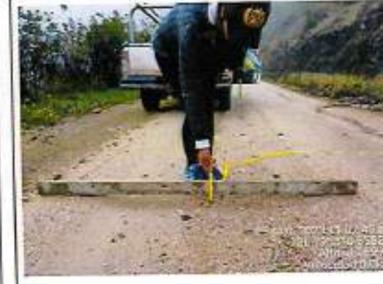
Foto 66: Espesor de afirmado - Progresiva 53+100
