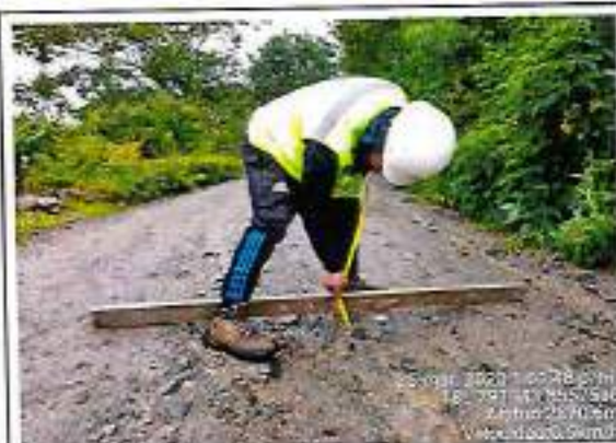
Foto 143: Ahuellamiento, erosión y baches - progresiva km 66+500
