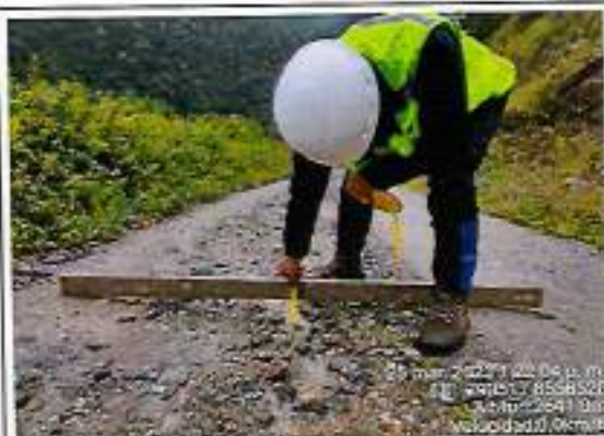
Foto 159: Erosion ahuellamiento y baches - progresiva 69+500
