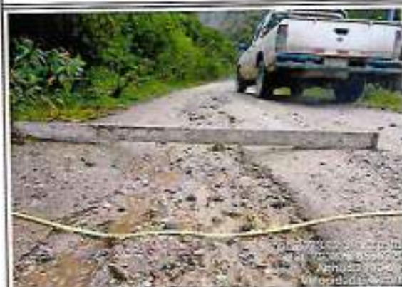
Foto 121: Espesor de afirmado - progresiva km 62+340
