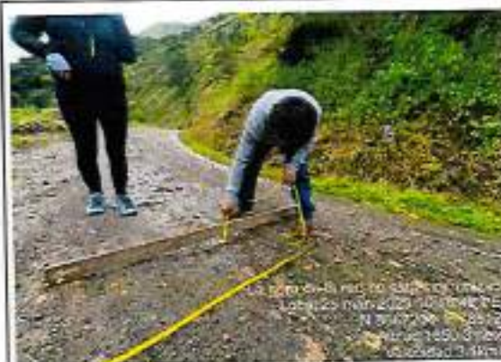
Foto 230: Ahuellamiento erosión y baches - progresiva km 84+910
