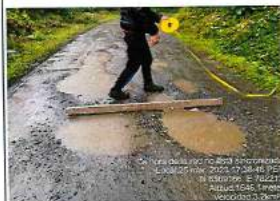
Foto 253: ahuellamiento erosion y baches - progresiva km 91+000
