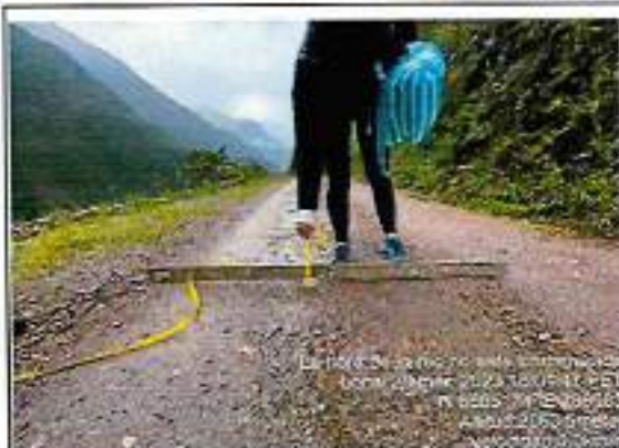
Foto 208: Ahueamiento erosión y baches - progresiva km 80+000
