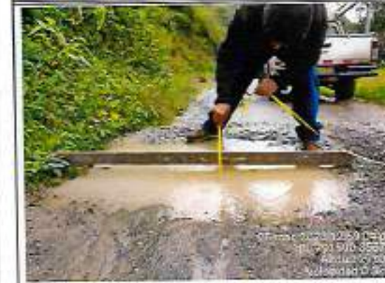
Foto 142: espesor de afirmado - progresiva km 66+080
