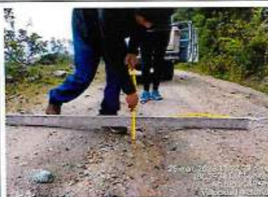
Foto 118: Espesor de afirmado - progresiva km 61+400
