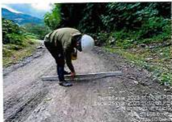
Foto 287: Erosion ahueflamiento y baches - progresiva km 98+000
