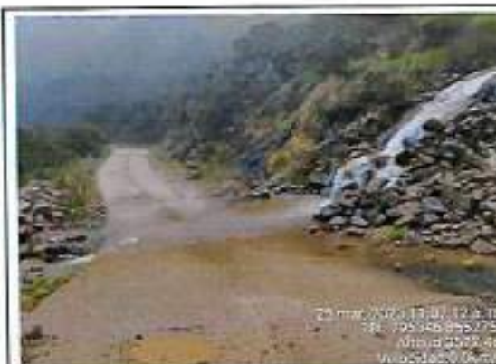
Foto 69: Baden de concreto armado - Progresiva 53+420
