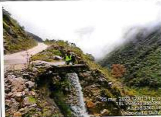
Foto 84: Punto Critico (Baden en riesgo de colapso) - Progresiva km 55+760
