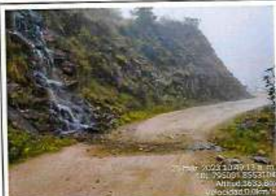
Foto 59: Erosion, Ahuellamiento y Baches - Progresiva km 52+500
