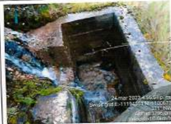
Foto 30: Alcantarilla TMC 24" - Progresiva 48+395
