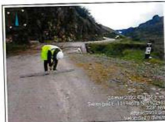
Foto 11: Ahuellamiento, Erosión y Baches - Progresiva km 45+720
