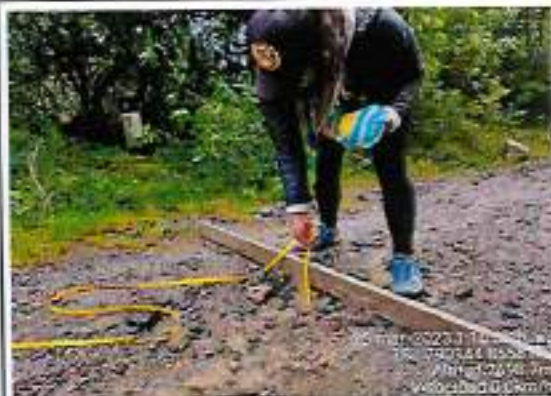
Foto 156: Ahuellamiento erosion y baches - progresiva km 68+910
