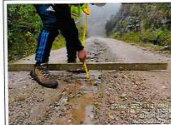
Foto 72: Espesor de afirmado - Progresiva km 53+900
