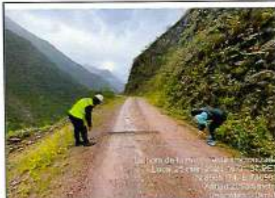
Foto 207: Ahuellamiento erosión y beches - progresiva km 79+340
