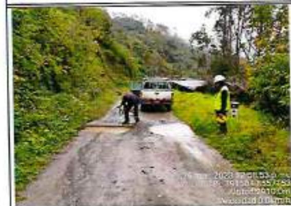
Foto 139: Ahuellamiento Erosion y baches - progresiva 66+130
