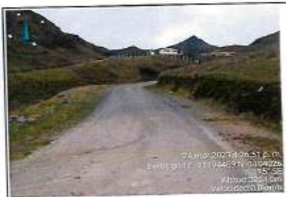
Foto 04: Ahueamiento, erosion y baches - progresiva 45+200
