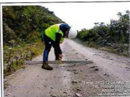
Foto 108: Espesor de afirmado - progresiva km 60+000
