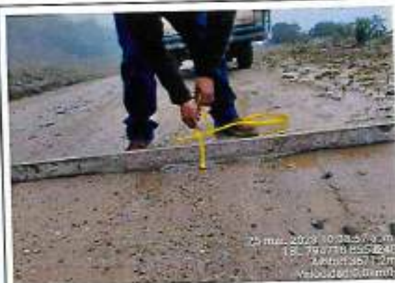
Foto 50: Espesor de afirmado - Progresiva km 51+000
