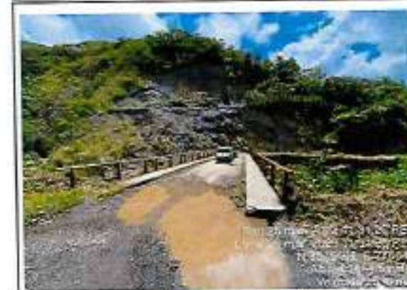
Foto 301: Ahuellamiento erosion y baches - progresiva km 101+500
