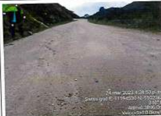
Foto 16: Ahuellamiento, Erosion y Bacheo - Progresiva km 46+000
