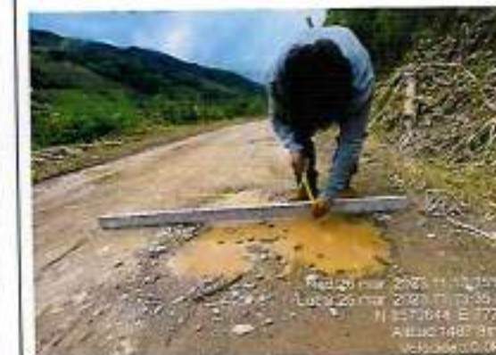
Foto 292: Ahueflamiento baches y erosion - progresiva km 98+700
