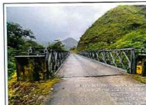
Foto 233: Ancho de vía y amueblamiento erosión y baches - progresiva km 86+500
