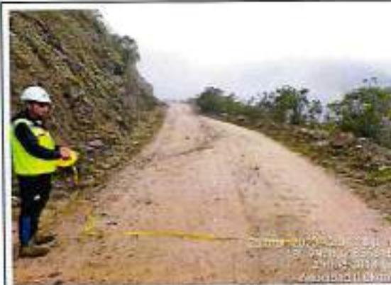
Foto 118: Ahuellamiento, erosion y Baches - progresiva km 62+000
