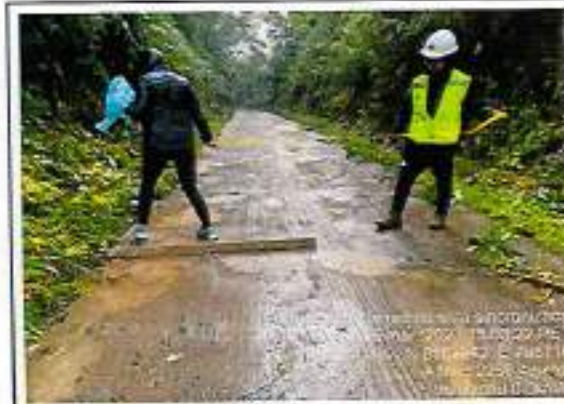
Foto 188: ahuecamiento erosión y baches - progresiva 75+500
