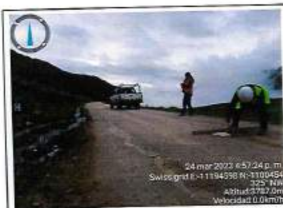
Foto 32: Ahuellamiento, bache y Erosion - Progresiva km 48+520
