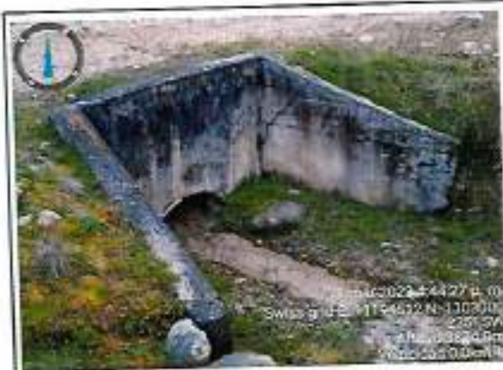
Foto 21: Alcantarilla TMC 36" - Progresiva km 46+800
