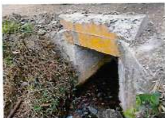
Foto 219: Alcantarilla tipo marco - progresiva 82+380
