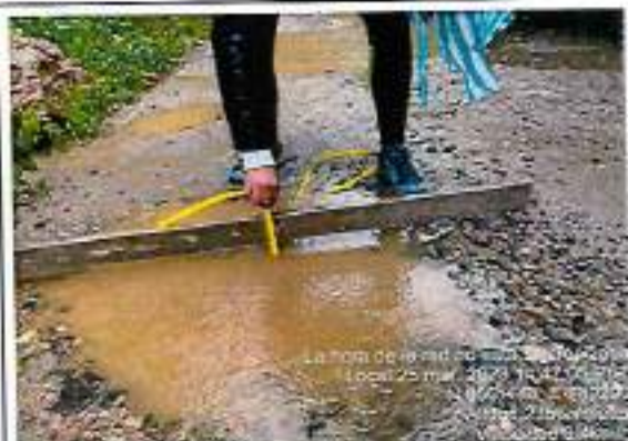
Foto 179: Ahuellamiento erosion y baches - progresiva km 73+500
