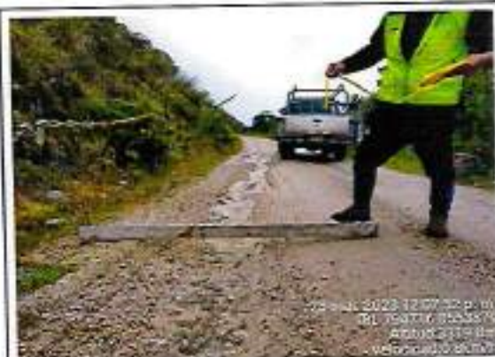
Foto 93: Ahuellamiento, Baches y Erosion - Progresiva km 57+200
