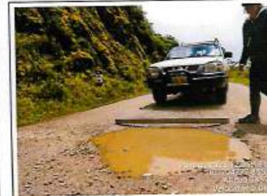
Foto 90: Ahuellamiento, Erosion y Baches - Progresiva km 56+800
