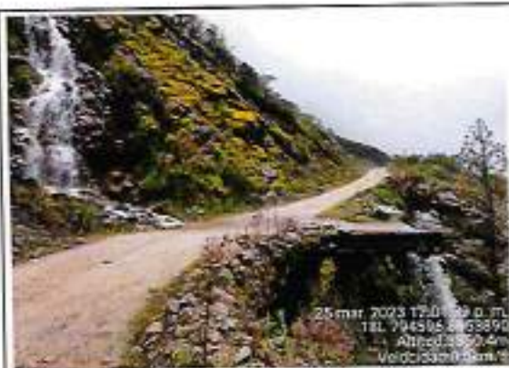
Foto 85: Baden de concreto Armado - Progresiva km 55+760
