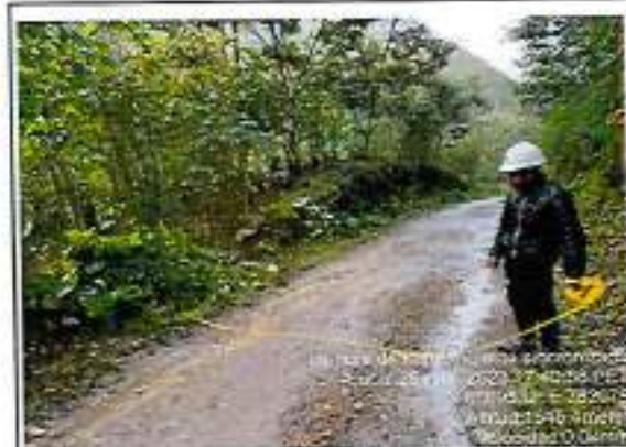
Foto 255: Erosion ahuellamiento baches - progresiva km 91+500
