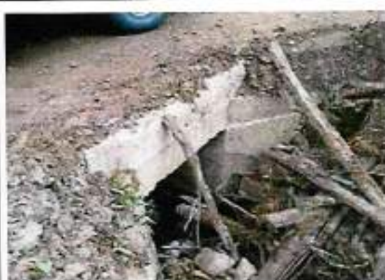
Foto 208: Alcantarilla tipo marco - progresiva km 79+460
