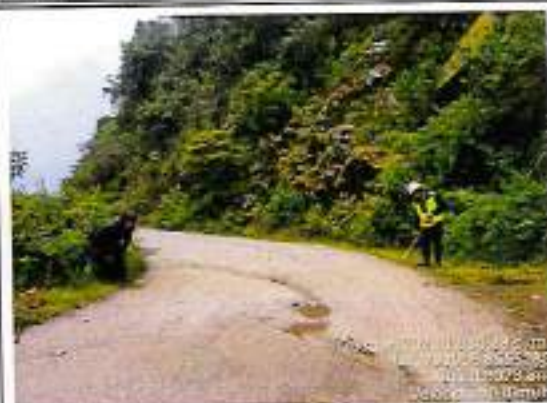
Foto 112: Ahueamiento, Erosion y Baches - Progresiva km 60+470
