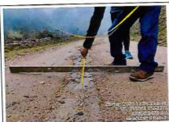
Foto 79: Anuelamiento, Erosion y Baches - Progresiva km 55+000
