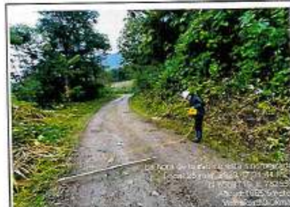
Foto 249: erosión Ahuellamiento y beches - progresiva km 90+000
