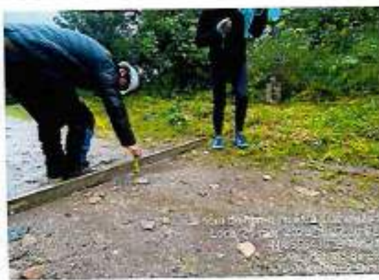
Foto 224: Espesor de afirmado - progresiva km 82+750
