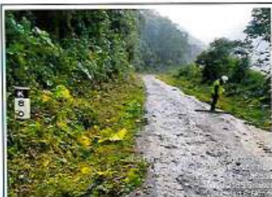
Foto 197: Ahuellamiento erosión y baches - progresiva 78+320
