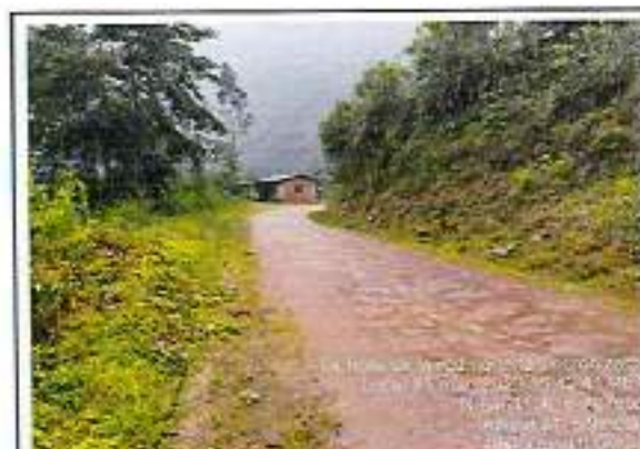
Foto 199: Ahuellamiento, erosión y baches - progresiva 78+500
