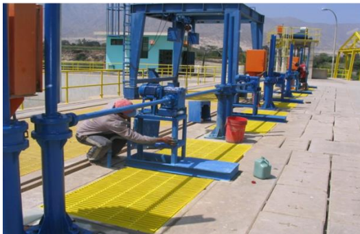
Mantenimiento de mecanismos de izaje, tableros y compuerta vagón
