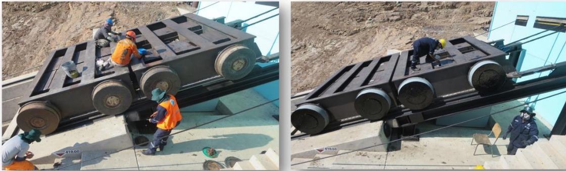
Mantenimiento de la compuerta vagón
