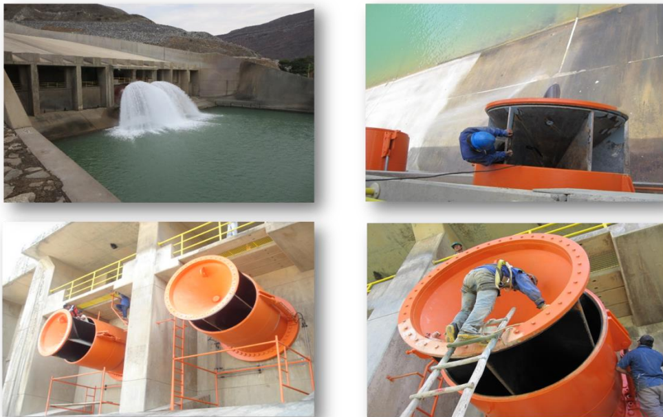
Mantenimiento en central, minicentral y válvulas reductoras de presión
