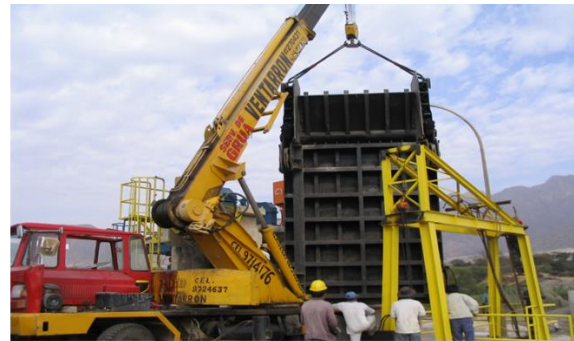
Mantenimiento de mecanismos de izaje, tableros y compuerta vagón
