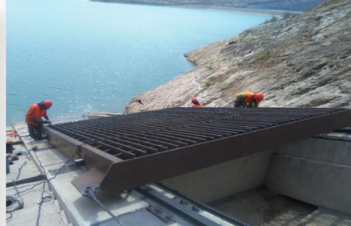
Mantenimiento en casa de máquinas de reja móvil
