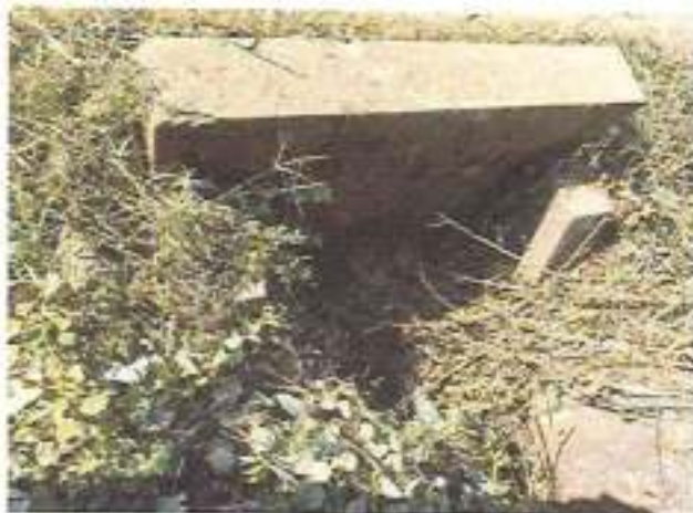
Foto N° 265 PROGRESIVA 45+140 DESCRIPCION Alcantarilla para limpiar
