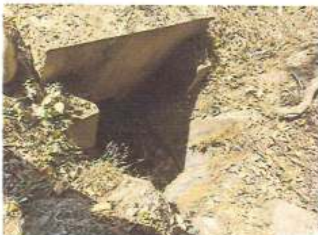
Foto N° 267 PROGRESIVA 47+260 DESCRIPCION Alcantarilla para limpiar
