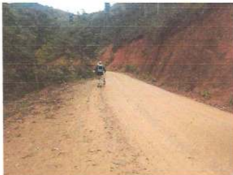
Talud demasiado empinado, posible lugar de derrumbes.
