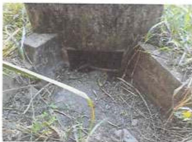
Foto N° 260 PROGRESIVA 40+360 DESCRIPCION Alcantarilla para limpiar
