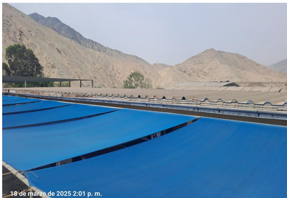
Imagen N° 3 Cobertura metálica con falta de mantenimiento ubicado sobre el segundo nivel del pabellón de aulas de dos niveles
