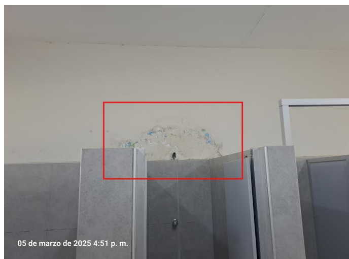
Imagen N° 19: Deterioro en la pintura de muros al interior de los ambientes de servicios higiénicos del patio
