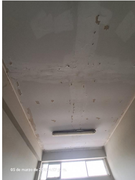
Imagen N° 11 Falta de mantenimiento en techos de los servicios higiénicos del segundo nivel del pabellón de aulas
