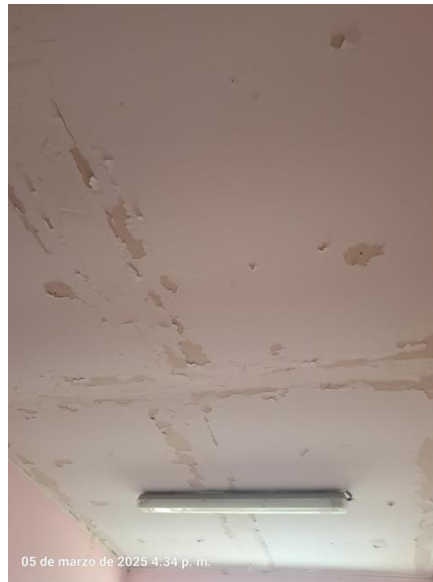
Imagen N° 13: Pérdida de pintura de techos de los servicios higiénicos del segundo nivel
