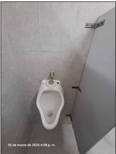
05 de marzo de 2025 4:08 p. m. Desmontaje, Suministro e Instalación Grifería de los Urinarios.
