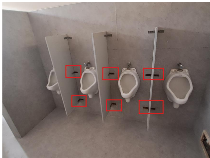
Imagen N° 10: Conexiones oxidadas en divisiones de urinarios
