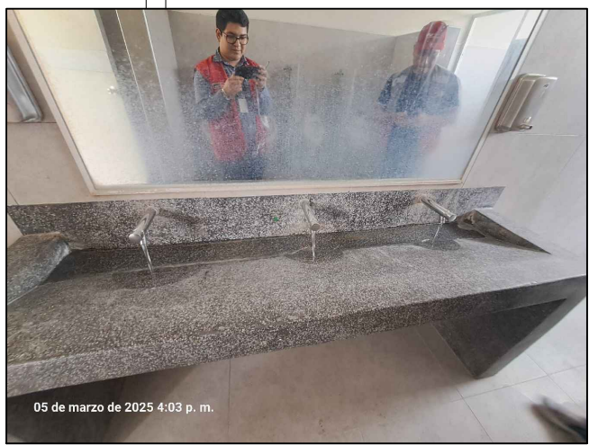
05 de marzo de 2025 4:03 p. m. Desmontaje, Suministro e Instalación la Grifería de Lavaderos.
