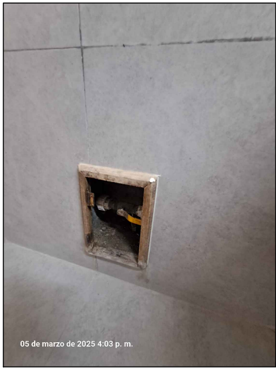
05 de marzo de 2025 4:03 p. m. Suministro e Instalación de la Tapa de Madera de Caja de Válvulas.
