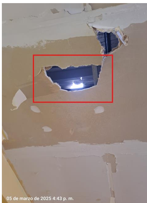
Imagen N° 23: Daños en cobertura de pabellón de aulas
