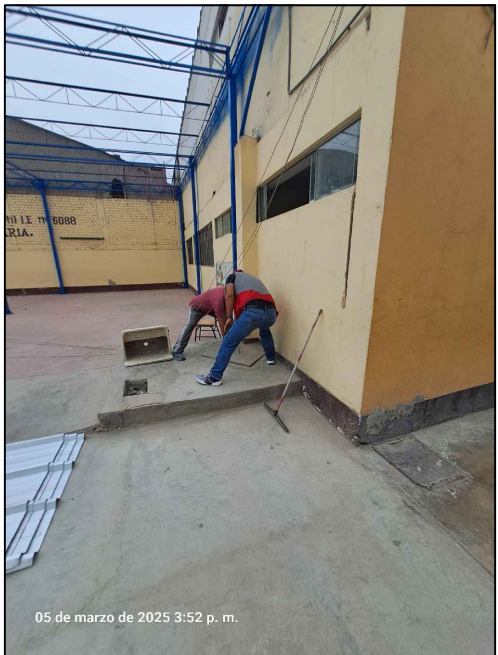
05 de marzo de 2025 3:52 p. m. Picado, Suministro e Instalación del Tubería de Ventilación
