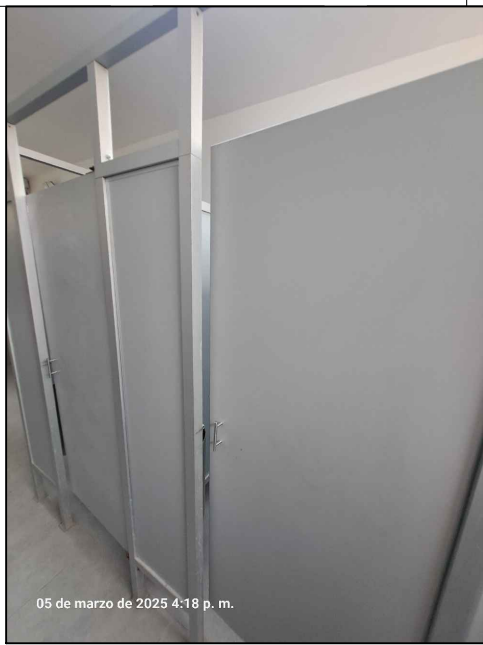
05 de marzo de 2025 4:18 p. m. Suministro e Instalación de Angulos de Soporte de Puertas de los Ss.Hh.
