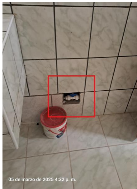
Imagen N° 15: Falta de tapas de cajas para válvulas de pase
