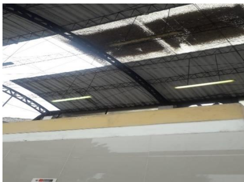
Foto N° 3: Se observa poca iluminación de luminarias existentes y falta de luminarias
