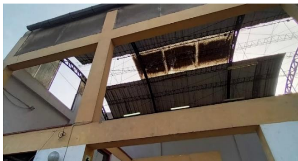
Foto N° 02: Se observa el mal estado del cerramiento lateral de la Planta de Residuos Sólidos. Zonas n sin cerramiento lateral.
